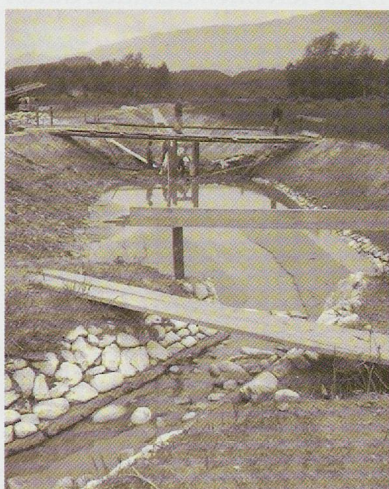
Fig. 336 — Anlage eines Entwässerungskanal im Jahre 1942.
