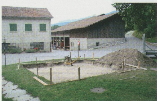
Fig. 350 — La surface a été excavée et le fond damé pour fournir une assise stable à la construction. Vue depuis le sud-est.
