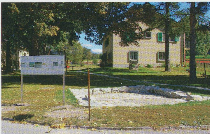
Fig. 354 — La ruine dans son état final (septembre 2010), accompagnée d'un panneau explicatif sur l'architecture et le contexte de découverte de la grange-écurie. Vue depuis l'ouest.
