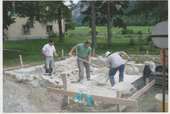
Fig. 351 — Les maçonneries ont été réalisées avec un mortier composé de sable, de gravier et de chaux hydratée. Vue depuis le nord.
