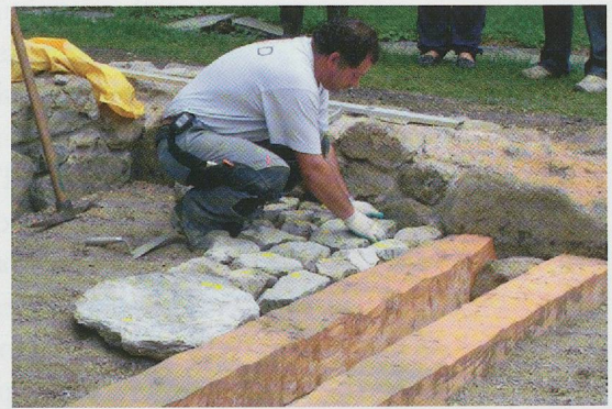
Fig. 352 — Les pierres du sol, préalablement numérotées, ont été installées sur un lit constitué d'un mélange de chaux et de sable fin. La rigole centrale a été reconstruite avec de nouvelles poutres en mélèze.
