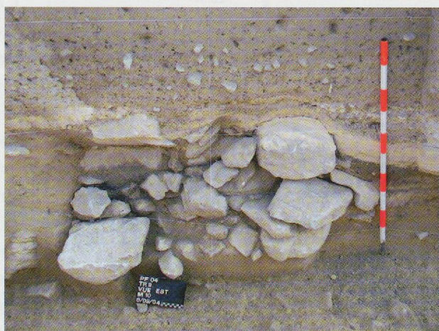
Fig. 169 — Zone 2, tranchée 9. Le mur présente deux parements de gros blocs et un blocage interne de caillasses. Vue en coupe depuis le sud-ouest.
