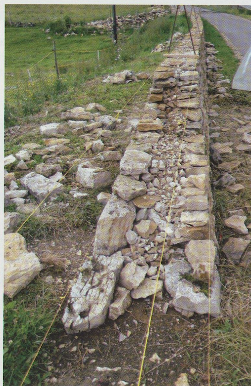
Fig. 172 — Mur moderne monté « à sec » en cours de construction le long d'une route des Franches-Montagnes (Jura, juillet 2009). Ses caractéristiques techniques (dimensions, double parement, blocage interne, section trapézoïdale) sont très proches de celles du mur de Pfyngut daté de l'Antiquité tardive.
