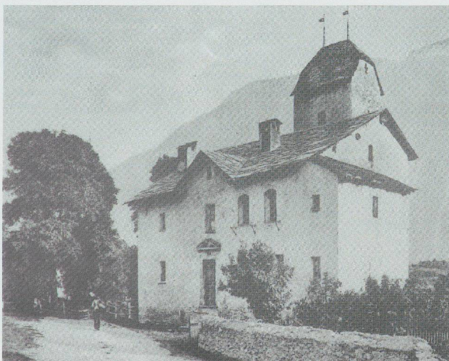
Fig. 47 — Salgesch. Cure et ancien hospice des chevaliers de Saint-Jean. Tiré de SCHMID et al. 1982, p. 25. Vue depuis l'ouest.
