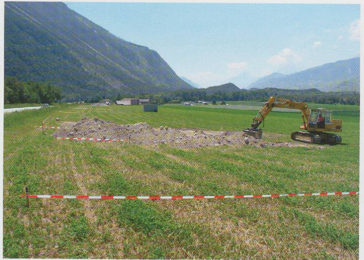
Fig. 7 — Tranchées complémentaires de 2005, au nord-est de la route cantonale. Vue depuis l'est.
