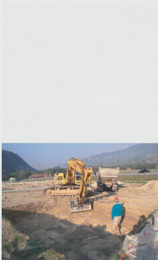
Fig. 17 — Zone 2. Décapage à la pelleuse jusque sur la surface organique du paléosol médiéval (PAL.04). Vue depuis l'est.
