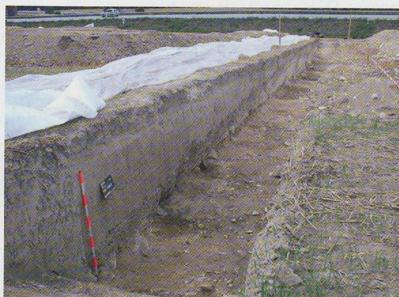
Fig. 12 — Les tranchées complémentaires (ici la tranchée 6) ont été creusées sur la largeur prévue de l'excavation de l'autoroute, soit une quarantaine de mètres. Vue depuis l'est.
