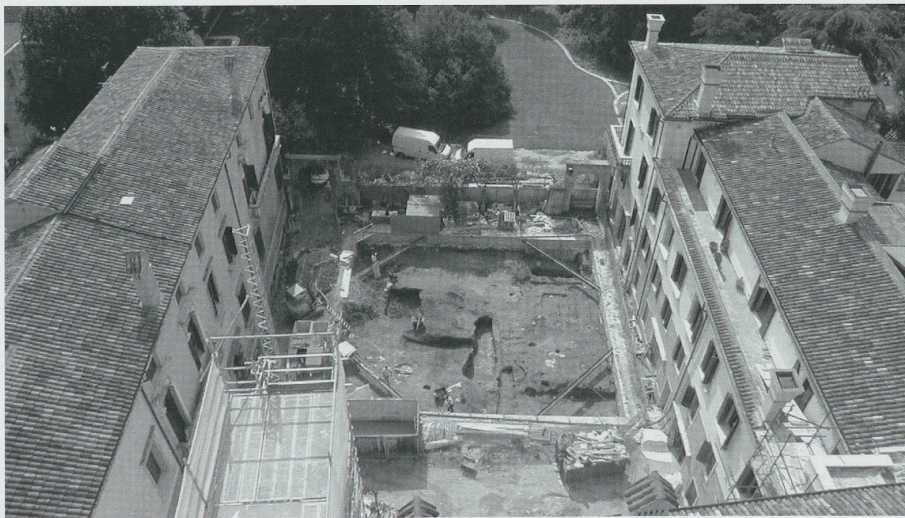
Fig. 3: Padova. Panoramica dello scavo nel cortile di palazzo Emo Capodilista, in corso Umberto I, nel 2002 (De Min et al., 2005).
