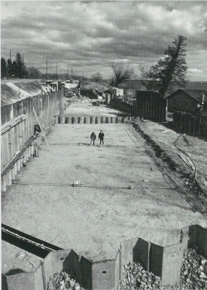
Fig. 7. Vue générale, en direction de l'est, de la zone 3 avant le début des travaux en mars 1999, après le décapage machine destiné à enlever les remblais de l'ancienne voie ferrée. Au centre du caisson ouest les deux personnes donnent l'échelle. Sur la droite, on remarque l'empreinte trapézoïdale de l'extrémité est de la zone 2.
