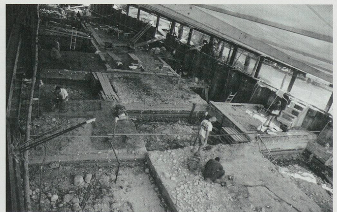
Fig. 11. Zone 2 en août 1997, vue en direction de l'est, deuxième phase des travaux. Les secteurs 117, au premier plan, 101 et 115 sont en cours de fouille, alors que le secteur 127 avec l'escalier est laissé pour permettre la sortie des fouilleurs et des sédiments vers l'extérieur.
