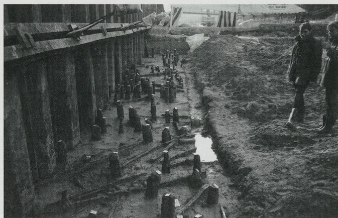
Fig. 10. Zone 1, vue en direction de l'ouest, fouille de la banquette témoin des secteurs 33c à 35 conservés le long des palplanches. Des bois couchés attribués au village néolithique moyen de l'ensemble E6 reposent sur une plage et sont recoupés par les pilotis des occupations plus récentes (ensembles E8, du Lüscherz ancien, et villages Bronze ancien des ensembles E11 et E12).
