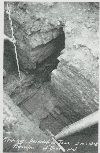
Fig. 28 Avenches, Derrière la Tour. Canalisation dégagée en 1938 dans l'aile thermale.
