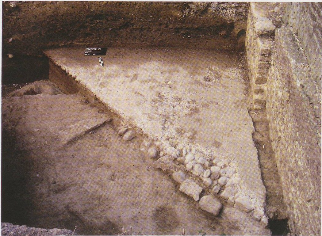
Abb. 36 S 13. Vortheaterzeitlicher Mörtelboden sol 9, welcher von der Umfassungsmauer des Theaters M 11 (rechts im Bild) durchschlagen wird.
