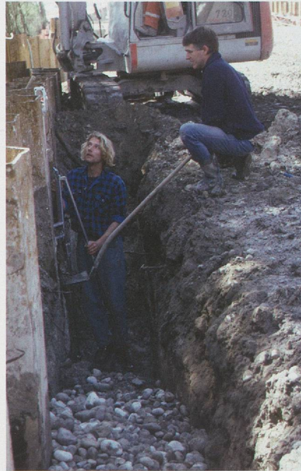
Pl. 1d. Mise en place des tranchées de drainage du caisson ouest de la zone 2 en avril 1997. Pour éviter leur effondrement, elles sont comblées au fur et à mesure par des galets.
