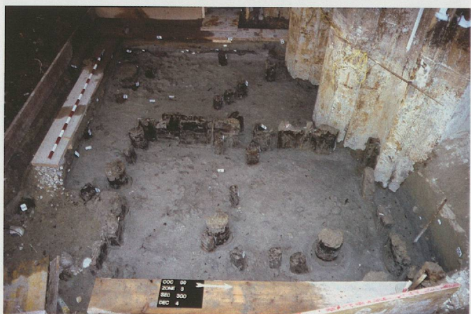
Pl. 2e. Le secteur 300 situé au sud du rideau de palplanches de la zone 3, en bordure du chemin du passage sous voie, n'a été que partiellement fouillé. Cette vue du décapage 4 depuis le côté est montre très nettement les fondations en bois de la structure moderne qui perturbent les couches préhistoriques.
