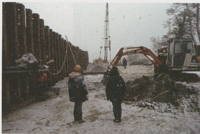
Pl. 2d. Surveillance du décapage machine dans le caisson principal de la zone 3 en février 1999. L'enlèvement de la base du remblai de l'ancienne voie est particulièrement délicat, il contient des milliers d'objets en position secondaire provenant du dragage effectué dans les stations lors de la construction en 1859, qu'il ne faut pas confondre avec les couches en place, sous peine de devoir les évacuer à la main.
