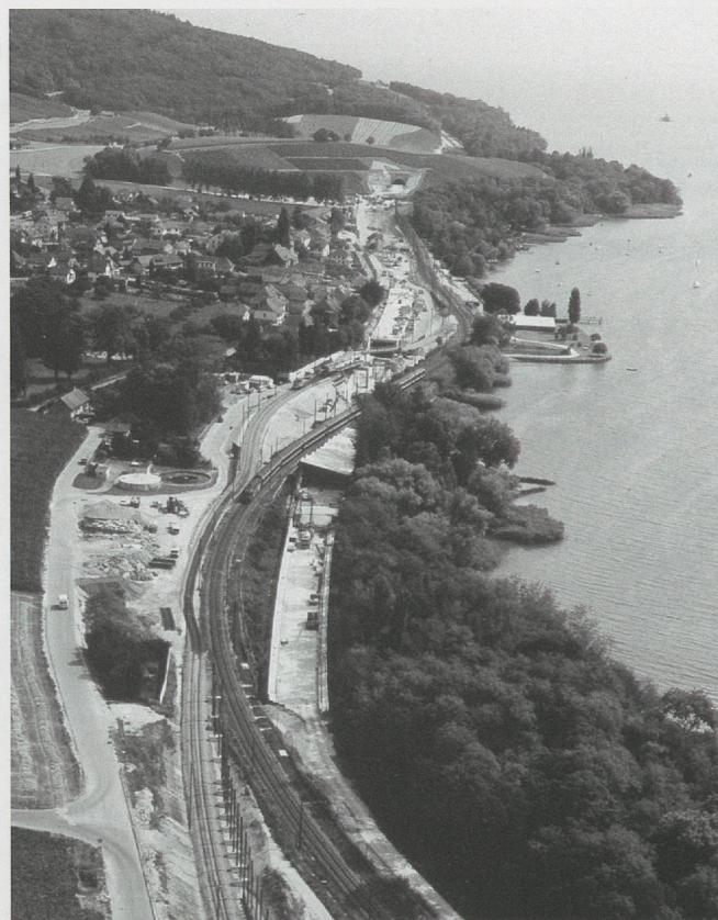
Fig. 4. Vue aérienne du chantier « Rail 2000 » en été 1998 montrant l'emprise des travaux dans la baie de Concise. A l'extrémité de la galerie déjà bétonnée, on trouve, coincée entre la ligne de chemin de fer et l'étroite bande littorale, la zone de fouille (zone 2) couverte par un toit. L'ancienne baie est comblée par les remblais modernes déversés après la première correction des eaux du Jura.
