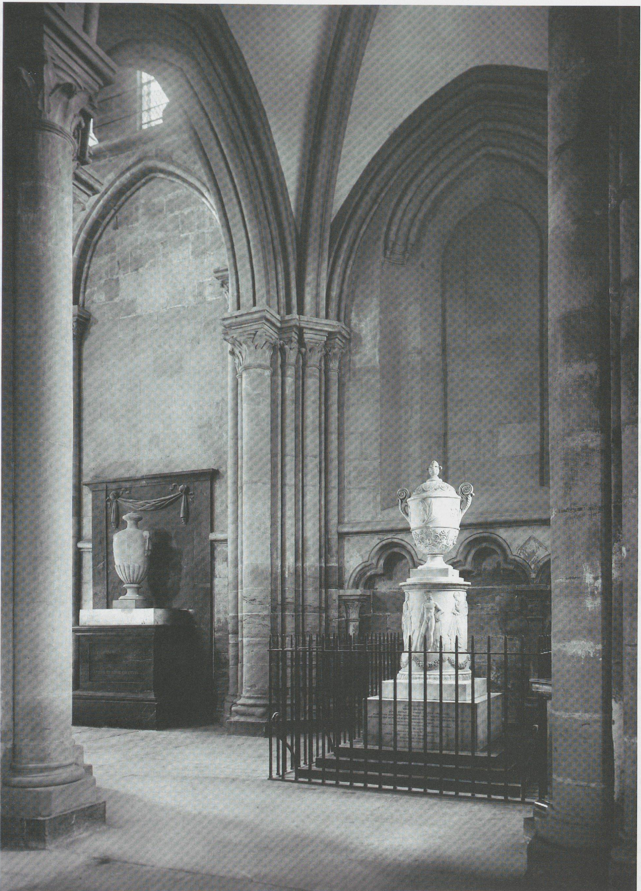
Fig. 43. Vue en direction du bras nord du transept, avec les monuments Canning (n° 47) et Walmoden (n° 41). Etat avant 1909.
