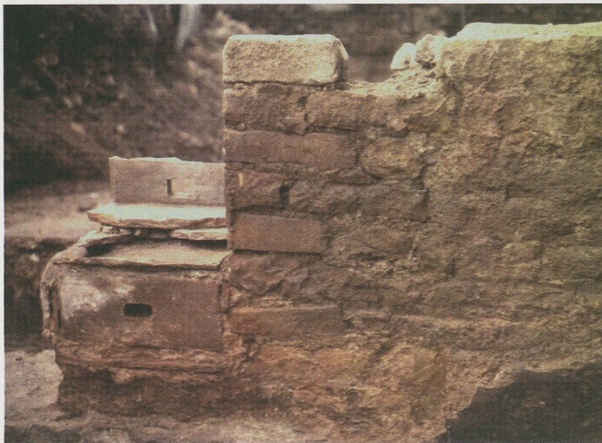
Fig. 106 Passage aménagé dans le mur M59 séparant la salle L32 du caldarium L33, à travers lequel l'air chaud circulait. Dans un deuxième temps, cette ouverture a été obturée par un bouchon de maçonnerie. Vue est.
