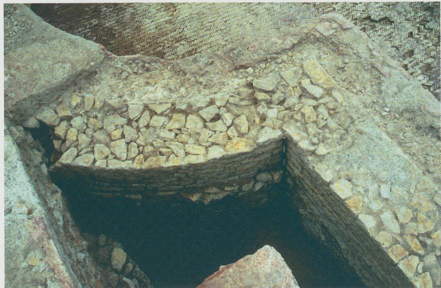
Fig. 38 Établissement tibérien. Les fondations montées à vue de l'abside de la piscine (M29). Vue sud.
