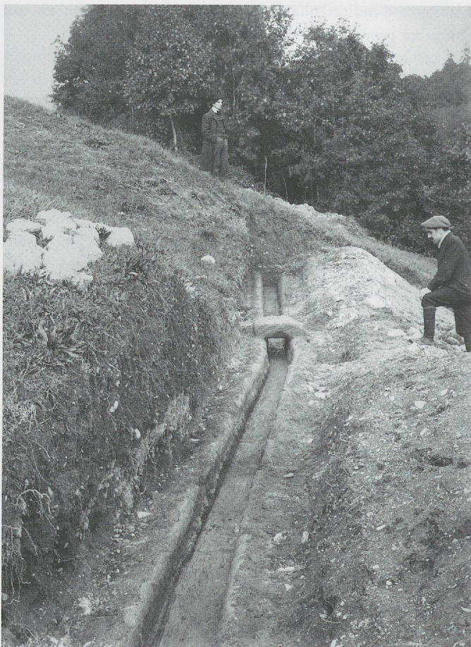
Fig. 206. Lousonna , Bois-de-Vaux, 1909. Tronçon de l'aqueduc partiellement mis au jour cette année-là, puis fouillé en 1922 par J. Gruaz. Il est constitué d'un canal maçonné dont le conduit interne, large de 30 cm environ, était revêtu de mortier au tuileau. Photo : R. Gindroz, Archives cantonales vaudoises, A70/1.1, A 5297.
