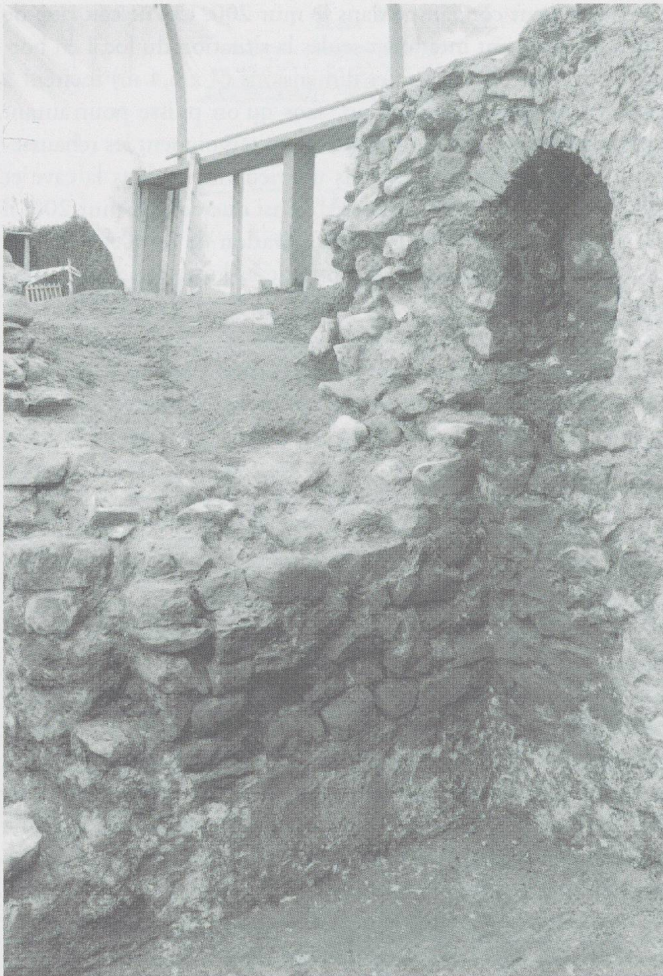
Fig. 111. Maison C, cave 3 (états 7-11). Angle formé par les murs sud et ouest. Le prélèvement du crépi a permis de mettre en évidence les chaînes d'angle assurant une cohésion optimale à l'ensemble du local. Photo Fibbi-Aeppli, Grandson.
