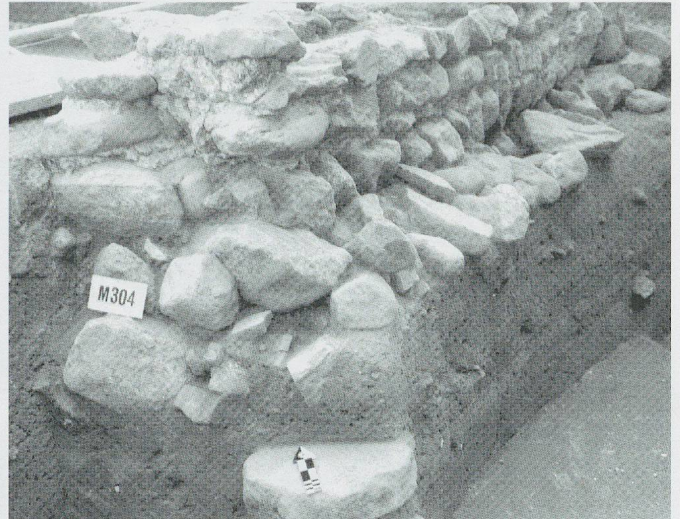
Fig. 135. Maison B (état 9). Parement est du mur 304, dont la fondation est décalée vers l'est. Vue nord-ouest.
