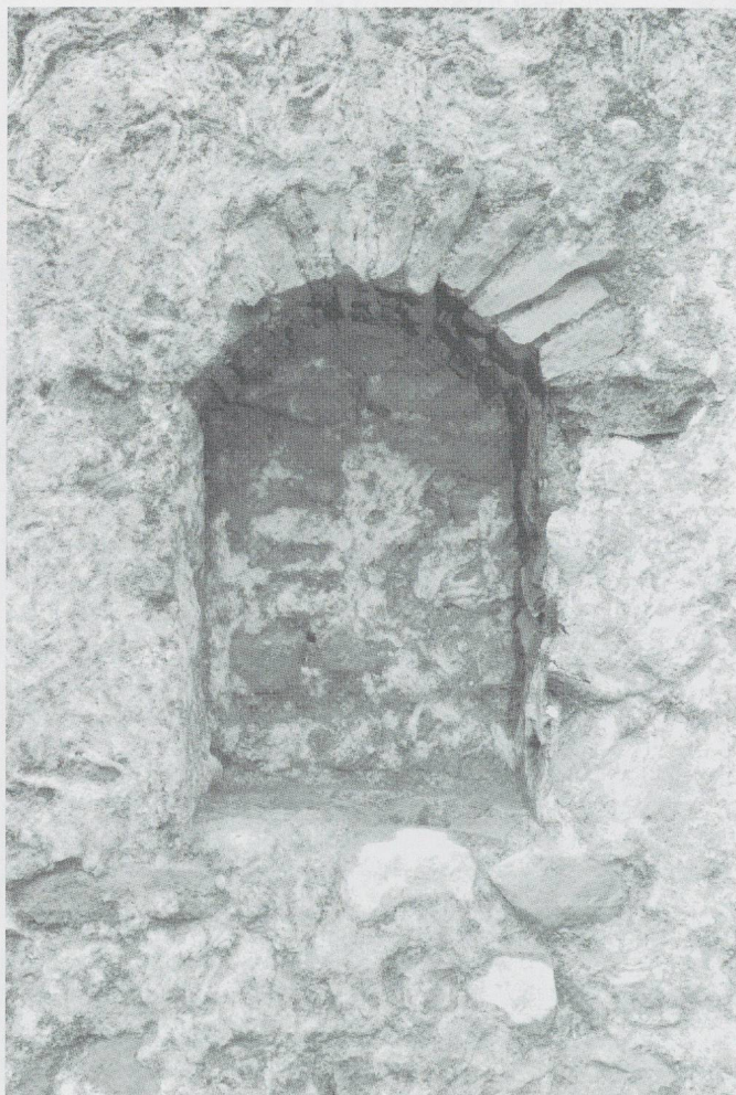
Fig. 113. Maison C, cave 3 (états 7-11). Une des niches du mur ouest, à l'origine entièrement revêtues de crépi. La voûte est constituée de dallettes de terre cuite. Photo Fibbi-Aeppli, Grandson.
