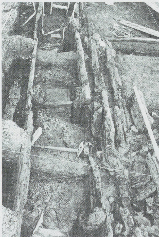
Fig. 202. Oberwinterthur, Unteres Bühl. Canalisation de bois pour les eaux usées et pluviales. Une couverture de planches est encore attestée par endroits. Ce sont des égouts de ce type qui étaient aménagés en bordure de la rue principale, à « Chavannes 11 ». Tiré de ASSPA, 65, 1982, p. 217, fig. 57.
