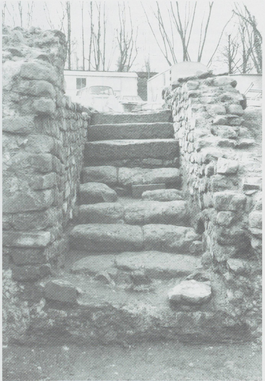
Fig. 175. Maison C (états 7-11). Cave 3, extrémité inférieure de la cage d'escalier: les angles des murs sont soigneusement exécutés en blocs de molasse disposés en boutisse et panneresse. Photo Fibbi-Aeppli, Grandson.
