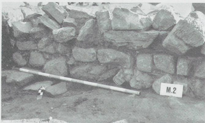
Fig. 174. Maison A (états 7-11). Elévation du mur 2. On distingue clairement l'arase du premier état du mur, surmontée par des assises moins soignées faisant partie d'un rehaussement de la maçonnerie intervenu à la fin du 2 e siècle.
