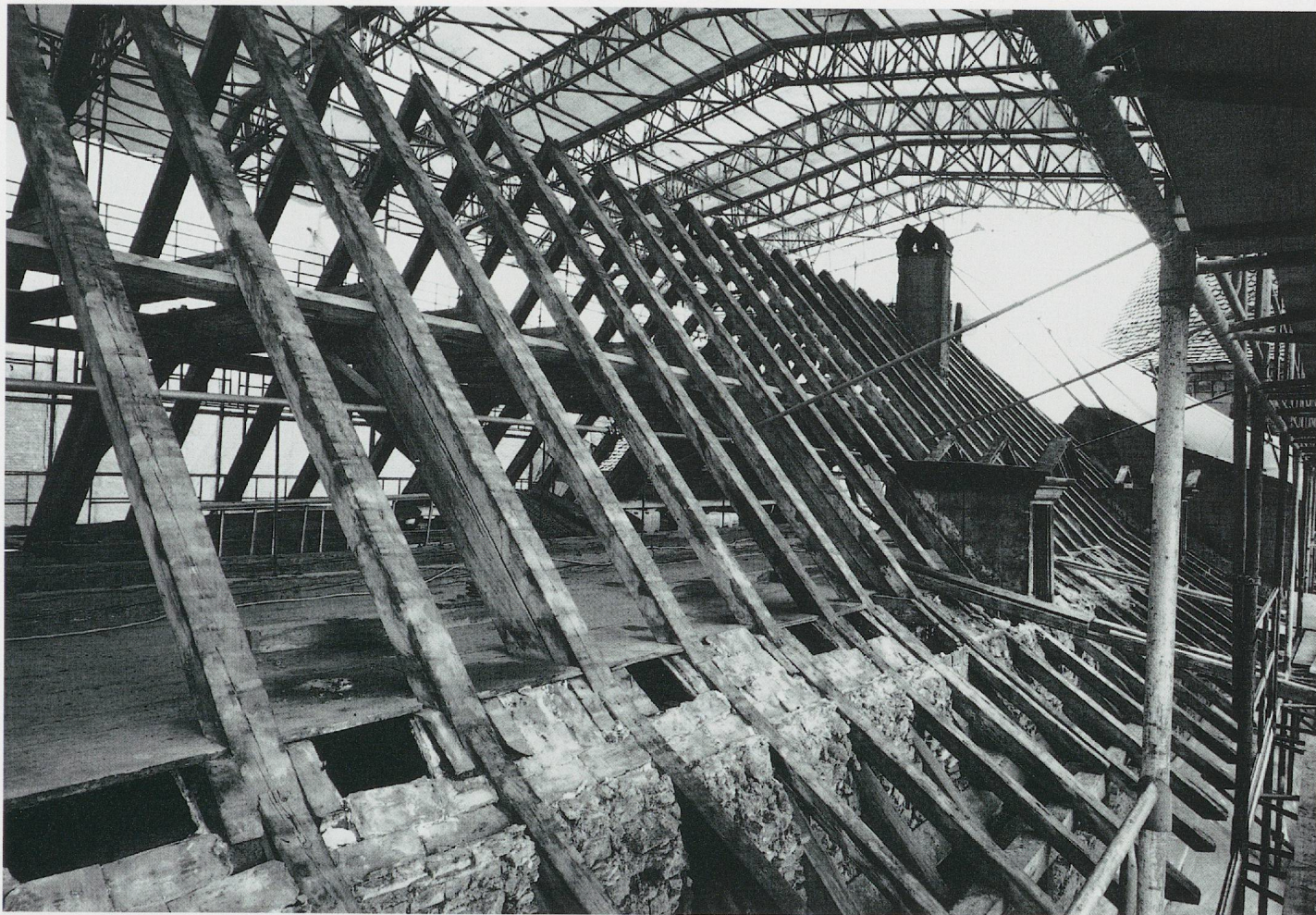
1080.1. Chantier de la réfection des couvertures, charpente de l'aile nord, de 1787. Etat en 1993. On a opté pour cette grande couverture provisoire sur structure tubulaire, d'une part pour améliorer le confort des travailleurs, d'autre part pour mieux prévenir les risques d'infiltration d'eau, fort préjudiciable pour les peintures bernoises. 2. Même chantier vu de l'ancien grenier bernois. Les bennes visibles ici rappellent que durant toute la durée des travaux, de 1990 à 2003, plus de 200 m 3 de matériaux divers, faisant partie peu ou prou de la substance historique de l'édifice, ont dû être évacués. (Fibbi-Aeppli)
