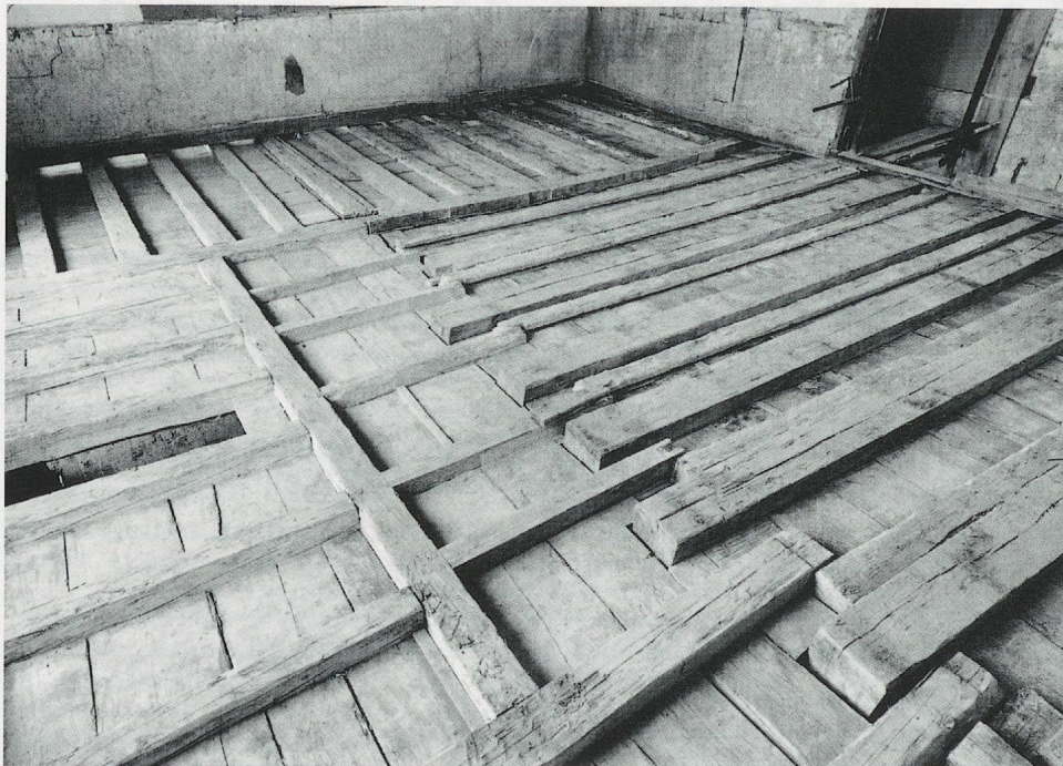
1073. Salle 305, Vue sur les planchers de la salle 306, en direction du nord. Etat en 1990. L'aspect très composite de ces structures s'explique par la progressive occupation dès 1650 du niveau inférieur. Au fur et à mesure de leur apparition, les chambres ont formé des sortes de caisses en bois qui se sont juxtaposées. Les poutres les plus fortes ont été posées en 1883 pour l'aménagement de salles de classe. Ces structures n'ont pas pu être conservées pour répondre aux normes de sécurité qu'exigeait l'espace public de la future salle d'exposition. (Fibbi-Aeppli)
