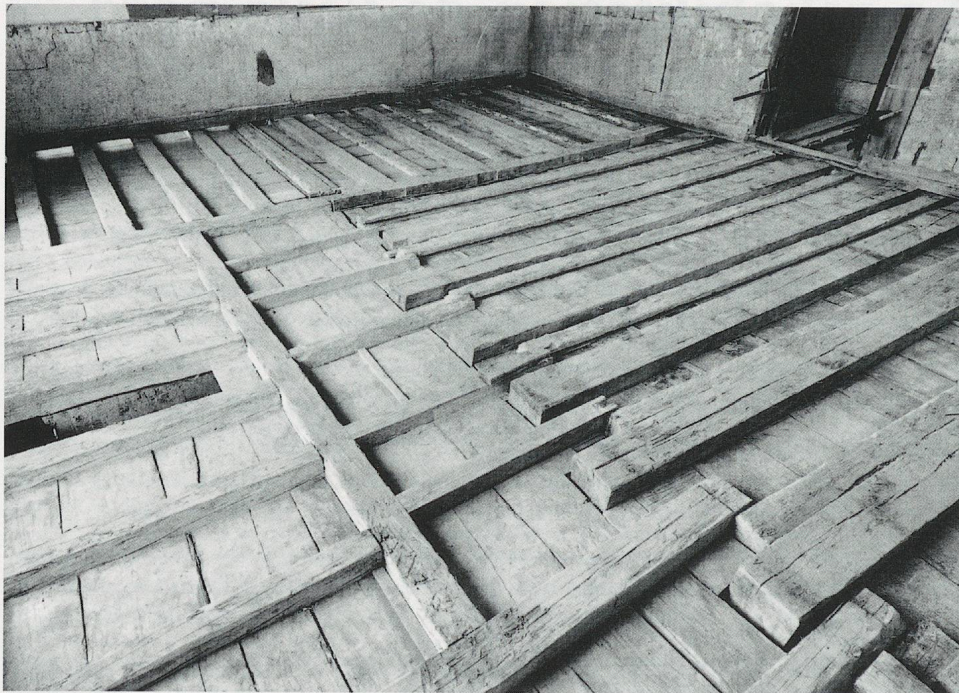
1073. Salle 305, Vue sur les planchers de la salle 306, en direction du nord. Etat en 1990. L'aspect très composite de ces structures s'explique par la progressive occupation dès 1650 du niveau inférieur. Au fur et à mesure de leur apparition, les chambres ont formé des sortes de caisses en bois qui se sont juxtaposées. Les poutres les plus fortes ont été posées en 1883 pour l'aménagement de salles de classe. Ces structures n'ont pas pu être conservées pour répondre aux normes de sécurité qu'exigeait l'espace public de la future salle d'exposition. (Fibbi-Aeppli)
