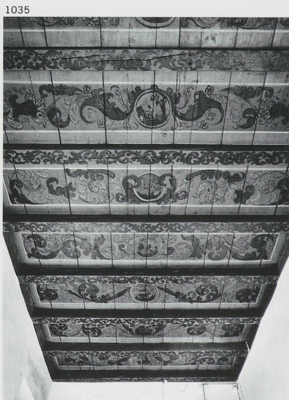
1035. Yverdon, la rue du Lac 26, plafond peint de la cage d'escalier, vers 1700. (R. Gindroz)
