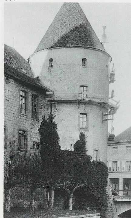
964. Château d'Yverdon, courtine orientale et tour des gardes. Décrépissage de cette dernière commencé à la fin de l'année 1918. Le parti d'ornez les murailles de végétation grimpante est apparu au début du siècle. Cette dernière s'est déjà largement déployée depuis les travaux de 1903-1906. Il faut observer la précarité des échafaudages, sur lesquels osaient se lancer les ouvriers. (AFMH)
