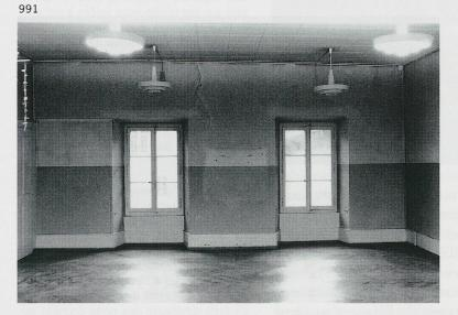
991. Château d'Yverdon, étage de l'aile sud, salle [219-4] vue en direction du nord. Le sol est formé d'un parquet en lamelles de sapin posées en chevrons, l'éclairage est celui en vigueur dans maints édifices scolaires dans les années 1960, les deux fenêtres donnant sur la cour seront remplacées par la restitution d'une croisée de 1494–1495. Etat en 1974. (P. Margot)
