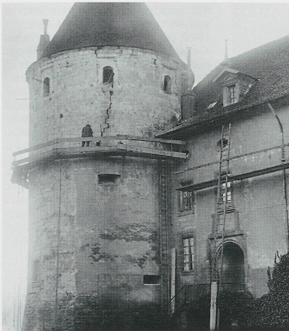
965. Château d'Yverdon, la tour des gardes en cours de décrépiage, fin 1918. Non seulement les percements anciens, mais d'importantes fissures sont mis au jour. (AFMH)
