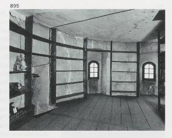
895. Château d'Yverdon, tour orientale, étage du couronnement, vue vers le sud. Etat en 1993. Le plafond en plâtre, l'enduit des parois, les châssis de fenêtre sur les jours de l'époque bernoise et le plancher à frises de chêne ont été posés en 1809 pour le cabinet de sciences naturelles de Pestalozzi déplacé en 1816 dans la tour des Juifs. Le plafond a été enlevé en 1994 afin de laisser visible la charpente de 1489. (Fibbi-Aeppli)
