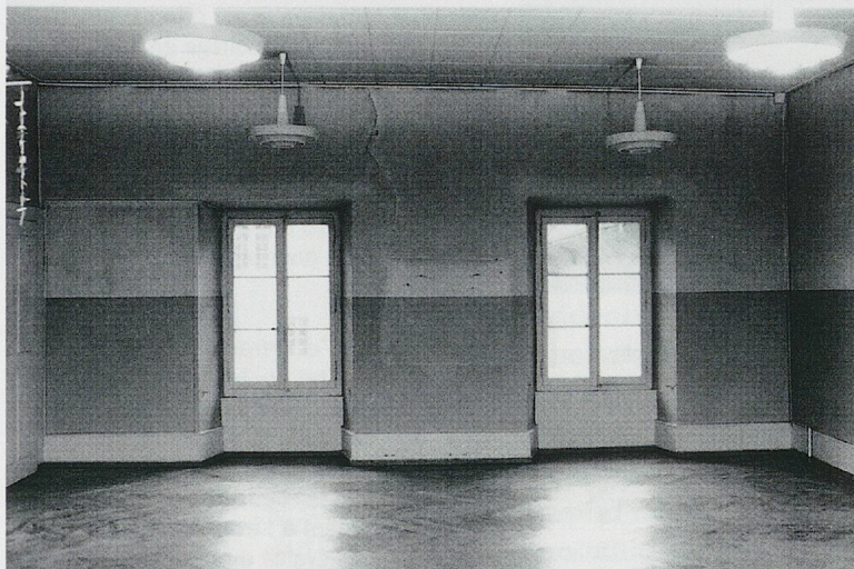
991. Château d'Yverdon, étage de l'aile sud, salle [219-4] vue en direction du nord. Le sol est formé d'un parquet en lamelles de sapin posées en chevrons, l'éclairage est celui en vigueur dans maints édifices scolaires dans les années 1960, les deux fenêtres donnant sur la cour seront remplacées par la restitution d'une croisée de 1494-1495. Etat en 1974. (P. Margot)
