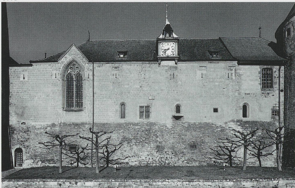
1000. Château d'Yverdon, étage de l'aile orientale [224], vue en direction du nord-est, détail montrant la reconstitution du chemin de ronde, en béton armé où il était originellement en encorbellement sur la portion de courtine mince, en molasse appareillée là où il était formé simplement par le retrait du mur, état en 1987. (P. Margot)
