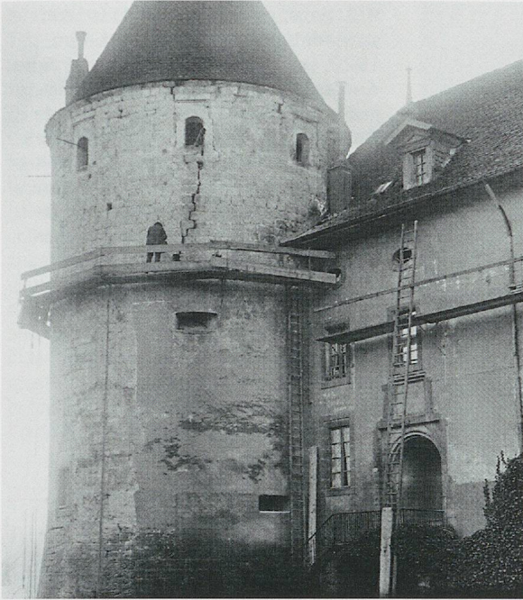
965. Château d'Yverdon, la tour des gardes en cours de décrépissage, fin 1918. Non seulement les percements anciens, mais d'importantes fissures sont mis au jour. (AFMH)
