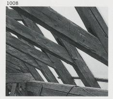
1008. Château d'Yverdon, aile orientale, chantier de réfection de la charpente. Etat début décembre 1998. Détail montrant le façonnage à la hache des poutres ainsi que les marques d'assemblage (ici 9, 10, 11, 12, etc.) sur l'aisselier renforçant et stabilisant le chevron et le fauxentrait, du côté de la cour intérieure. (D. de Raemy)
