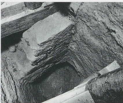
940. Château d'Yverdon, courtine sud, canal des latrines desservant la grande tour, partie inférieure. Vue plongeante depuis le passage de la poterne donnant accès à la cour de la grande tour. Au fond est visible le plan incliné qui permettait le rejet des matières vers l'extérieur. Etat en 1988. (Fibbi-Aeppli)
