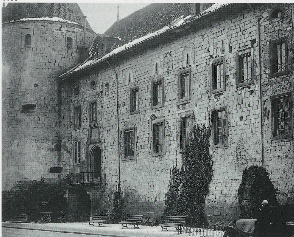
1011. Château d'Yverdon, vue sur la courtine nord, l'entrée et la tour orientale, 1929. L'appareil de molasse apparaît beaucoup moins érodé qu'à la veille du recrépissage. (AFMH)
