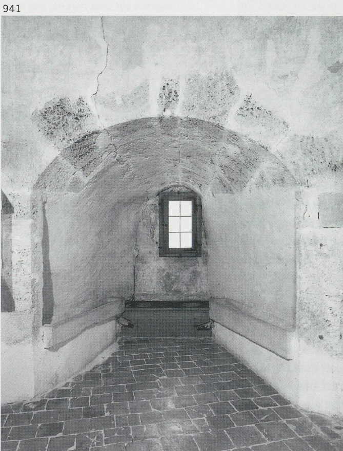
941. Château d'Yverdon, tour occidentale dite « des Juifs », 3 e niveau à la hauteur de l'étage des corps de logis adjacents. Dans l'embrasure de la fenêtre de 1605-1607 ont été aménagés en 1872 deux urinoirs allongés pour les élèves du collège. Etat en 1997. (Fibbi-Aeppli)
