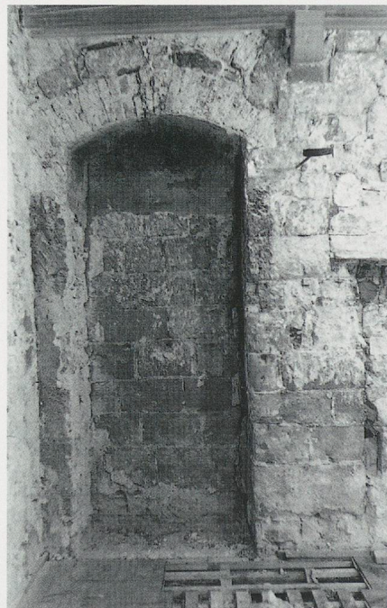
979. Château d'Yverdon, aile sud, ancienne salle «des armoiries» [120-5], vue sur la courtine sud, dans l'angle sud ouest de la pièce. Etat en 1961. La niche contenant le départ de l'escalier montant à la grande tour vient d'être mise au jour; son couvrement fait de deux arcs de terre cuite alternant avec des blocs de molasse en réemploi, ne saurait refléter l'état médiéval, inconnu. À droite, on voit un des montants du contrecœur de la cheminée de la camera domini . (P. Margot)
