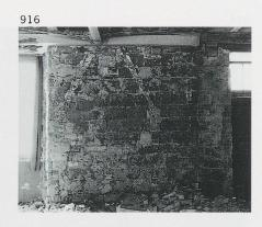
916. Château d'Yverdon, aile ouest, mur sur cour, vu de [115-3], restes de la hotte de cheminée créée en 1841 pour le laboratoire de chimie. Etat en 1967. L'embrasure de gauche, ayant contenu primitivement une fenêtre à meneau, a été agrandie en porte en 1838 pour le collège. Elle redevient fenêtre en 1841 pour le laboratoire. La porte de droite est une création nouvelle de 1857, toujours pour le collège. (P. Margot)
