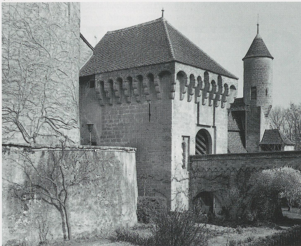
847. Estavayer-le-Lac, château de Chenaux, tour-porte donnant directement sur la campagne. Etat en 1998. On y trouve le couple classique de la porte charrière et de la porte piétonne, fermées à l'origine par des ponts-levis, ces derniers remplacés en 1770 par le pont en maçonnerie. À l'arrière, cette tour, ouverte à la gorge à l'origine, s'interrompait à la hauteur du mur de braies protégeant les lices, ininterrompues de la chemise de la grande tour (à gauche) jusqu'au pied de la tourelle marquant l'angle oriental du château (au second plan). (Fibbi-Aeppli)
