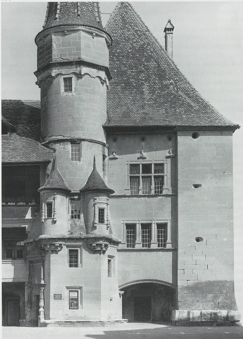
774. Château d'Avenches, vue vers le nord. Etat en 1995. Tour d'escalier, façade de la galerie et latrines plaquées entre 1565 et 1568 contre la grande tour quadrangulaire du XIV e siècle. (Cl. Bornand)
