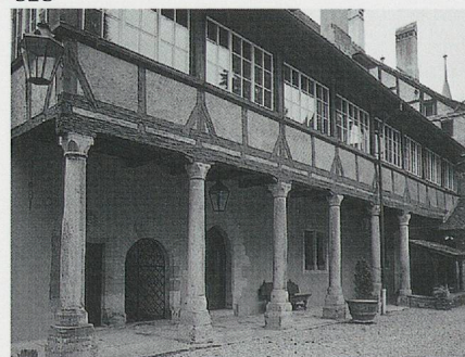
828. Château de Lucens, cour du plain-château et corps de logis de l'ancienne aula . Etat en 2003. (D. de Raemy)
