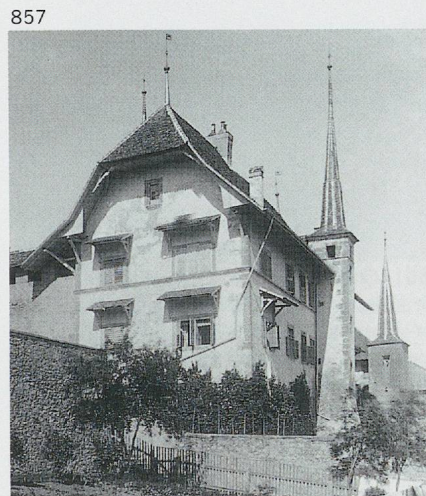
857. Château de Romont, corps de logis construit sur le front oriental en 1581–1587, après l'effondrement des édifices médiévaux, état en 1899. La tour-latrines, de petites proportions, est reliée par un corridor à la tour d'escalier polygonale donnant sur la cour intérieure. (SBC-FR)
