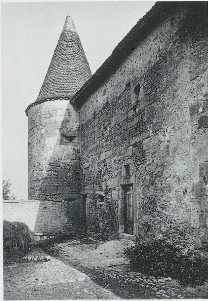
781. Château d'Avenches, tour semi-circulaire nord-ouest Q et courtine occidentale derrière la grange et les écuries, 1568. Etat en 1902. Au premier plan on remarque la pénétration du mur de ville médiéval. La tour, terminée par une frise de modillons, est percée de canonnières à ébrasement extérieur. (Fred. Boissonnas)
