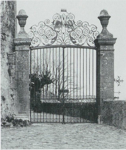
762. Château de Grandson, grille en fer forgé de 1758 prise sur d'anciens matériaux ferreux récupérés au couvent des Cordeliers. Les deux écus rococo reçoivent les armes de Berne et Fribourg par un peintre Droz du Locle. Etat en 1986. (Cl. Bornand)
