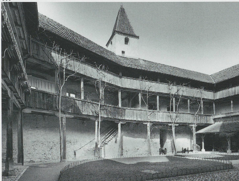
866. Château de Gruyères, cour intérieure. Galeries de bois appuyées après 1559 contre les courtines ouest et nord à l'emplacement des corps de logis qui auraient dû être édifiés dans les années 1480, comme pourrait le confirmer la frise de briques à dents d'engrenage au couronnement de la tour-latrines quadrangulaire. Etat en 1998. (Fibbi-Aeppli)
