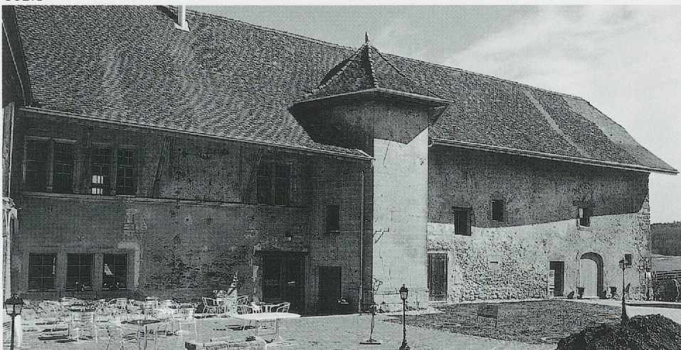
862.1 Château de Vuissens. Façade du grand corps de logis nord, vue de la cour intérieure. La tour d'escalier donne sur un corridor central aboutissant à des latrines accrochées sur la façade extérieure. Ce corridor n'est toutefois bordé que d'un seul mur en maçonnerie issu de l'édifice médiéval, l'autre étant en bois.
