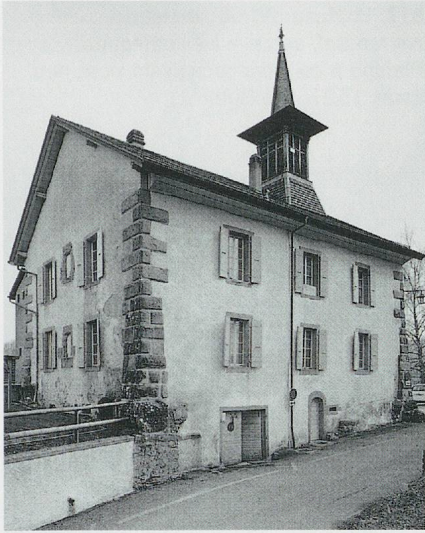
811. Oron-le-Châtel, ancienne école primaire communale. Les angles de cet édifice sont marqués par des chaînes et contreforts à bossages qui caractérisent les travaux d'Antoine Pauly en 1588–1590. Il abritait à l'origine un grenier dont on observe encore quelques fenêtres étroites, maintenant obturées. Etat en 2002. (R. Gindroz)
