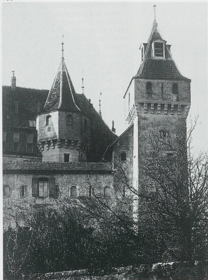
788. Château de Nyon, tour quadrangulaire dite « du bailli », par Antoine Vallon, après 1578, et courtine orientale définissant la cour intérieure. La tour commande le portail d'entrée, sur la façade nord. Le parapet du chemin de ronde présente une alternance de meurtrières à trou de serrure et de baies-créneaux en arc en plein cintre. La fenêtre à arc surbaissé a été percée en 1781–1782 pour tenter d'ouvrir le château sur l'extérieur. D'autres alors auraient dû être créées à côté d'elle. Etat vers 1915. (Musée historique de Nyon)
