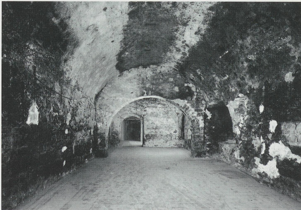
637. Château d'Yverdon, caves ouest [013 et 014], vues depuis le nord. Les voûtes en tuf, épaisses de 0,3 m environ, ont remplacé en 1536-1539 le double plancher en bois qui séparait les celliers des logis du rez-de-chaussée donnant sur la cour intérieure. L'embrasure des archères a été abaissée pour recevoir la retombée des voûtes. Le niveau du sol actuel est en gros celui du Moyen Âge. Etat en 1994, avant l'aménagement muséal pour l'exposition consacrée à la navigation romaine. (Fibbi-Aeppli)
