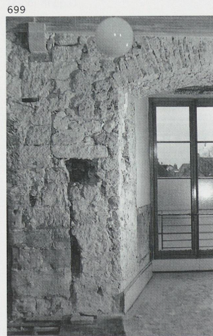
699. Château d'Yverdon, aile sud, rez-de-chaussée, salle [120-5], courtine sud. Etat en 1962. On voit le montant oriental, en molasse, de la cheminée de la camera domini . Celle-ci a été détruite lors de l'ouverture de la fenêtre en 1685. À meneau de pierre et à croisillon de bois probablement, cette dernière comportait une embrasure intérieure profonde sommée d'une voussure surbaissée de brique. Déjà changé en 1722 pour un encadrement simplement rectangulaire en pierre jaune de Hauterive, le jour a été agrandi en 1839 encore pour améliorer la lumière dans une salle de classe du collège. (P. Margot)
