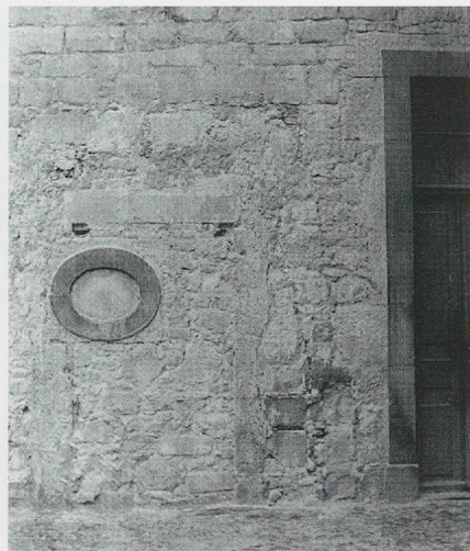
701. Château d'Yverdon, aile sud, façade sur la cour intérieure, partie ouest. Porte de 1700 donnant à l'origine dans la grande allée [120-1 à 4]. Etat après les décrépiages de 1956. Cette porte a remplacé l'accès direct depuis la cour à la nouvelle salle des armoiries; elle a été condamnée à la période scolaire, remplacée en 1841 par l'oculus éclairant la prison des écoles. À droite, la grande porte dans l'angle ouest de la cour, maintenant supprimée, remontait à ces mêmes travaux de 1841. (P. Margot)
