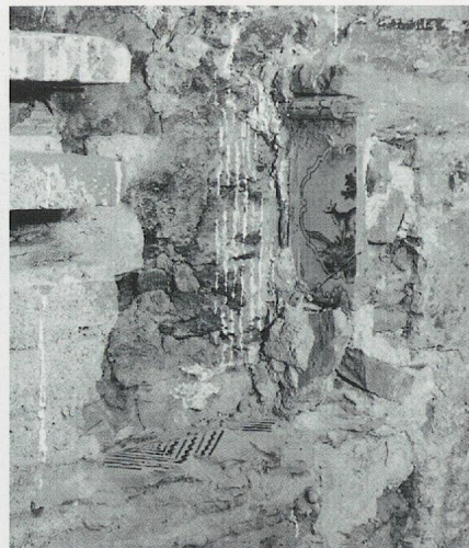
666. Château d'Yverdon, salle d'audience [109-1+106-3], restes de la banquette du poêle de 1752 occupant l'angle nord de la pièce, conservés dans l'épaisseur de la courtine où il formait une niche. Etat en 1997. (Fibbi-Aeppli)
