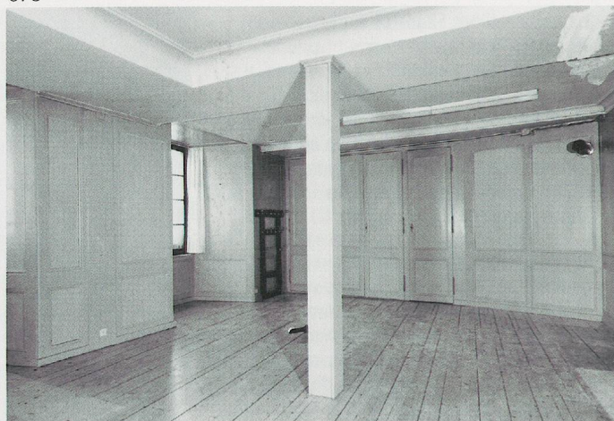
675. Château d'Yverdon, aile nord, rez-de-chaussée, espace [107-1 à 3], vue vers l'est, vers la salle d'audience de 1778. Etat en 1987. La fenêtre et les armoires sont de 1778. Un fourneau de faïence a été placé dans l'angle sud de la pièce, remplacé par la suite par des poêles en fer. (Fibbi-Aeppli)
