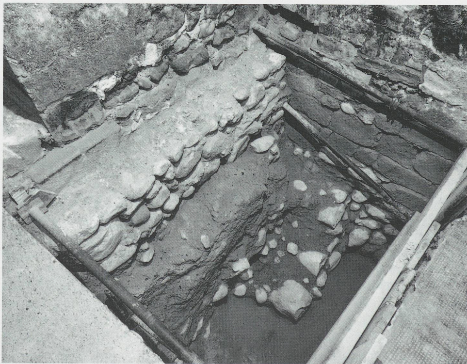
18. Château d'Yverdon, caves [006]. Au fond, extrémité nord du mur de courtine occidentale du château primitif. Au-dessus, terminaison nord du gros mur ayant supporté la façade sur cour de l' aula magna . Etat en 1994. (Fibbi-Aeppli)
