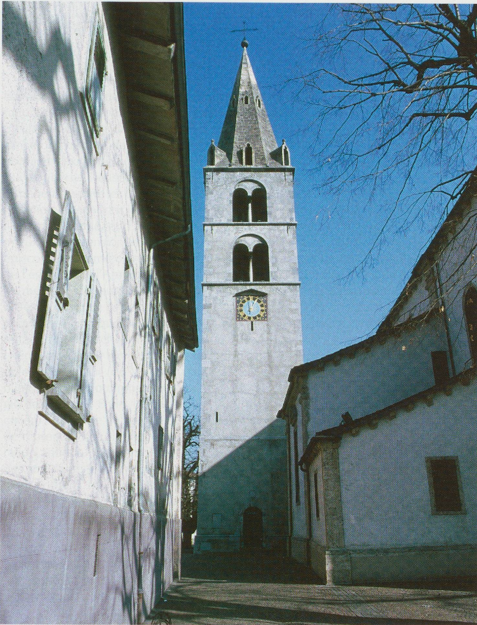
Fig. 50 : Vue du clocher dans son état actuel, depuis l'ouest.
