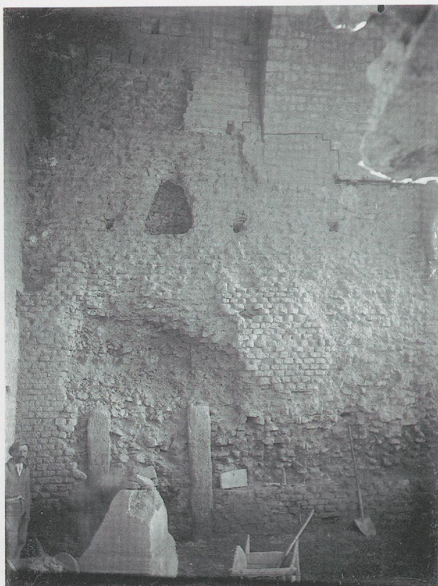
Fig. 20. Mur sud du passage axial M: au-dessus de la porte L, encore comblée de remblais et privée de linteau, cheminée de tirage du four à chaux installé tardivement dans le vestibule P adjacent; à droite en haut, naissance de la deuxième voûte en partie restaurée à l'intrados. 1919 (?).
