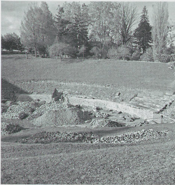
Fig. 26. La reconstruction du mur de podium est achevée dans le secteur nord-est, amorcée au nord-ouest, celle du carcer est en cours; quelques blocs de gradins authentiques ont été remis en place. 29 octobre 1946.
