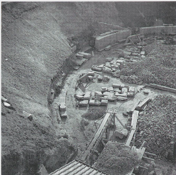
Fig. 30. Le tronçon sud-est du couloir de service est dégagé, mais son arrière-mur de podium n'est pas encore reconstruit sur l'assise de base en grands blocs, certains présentant l'ébauche de meules. La niche axiale 3 et son escalier ne sont pas encore restaurés, et la niche sud-est 4 n'est pas encore dégagée. 1 er octobre 1948.
