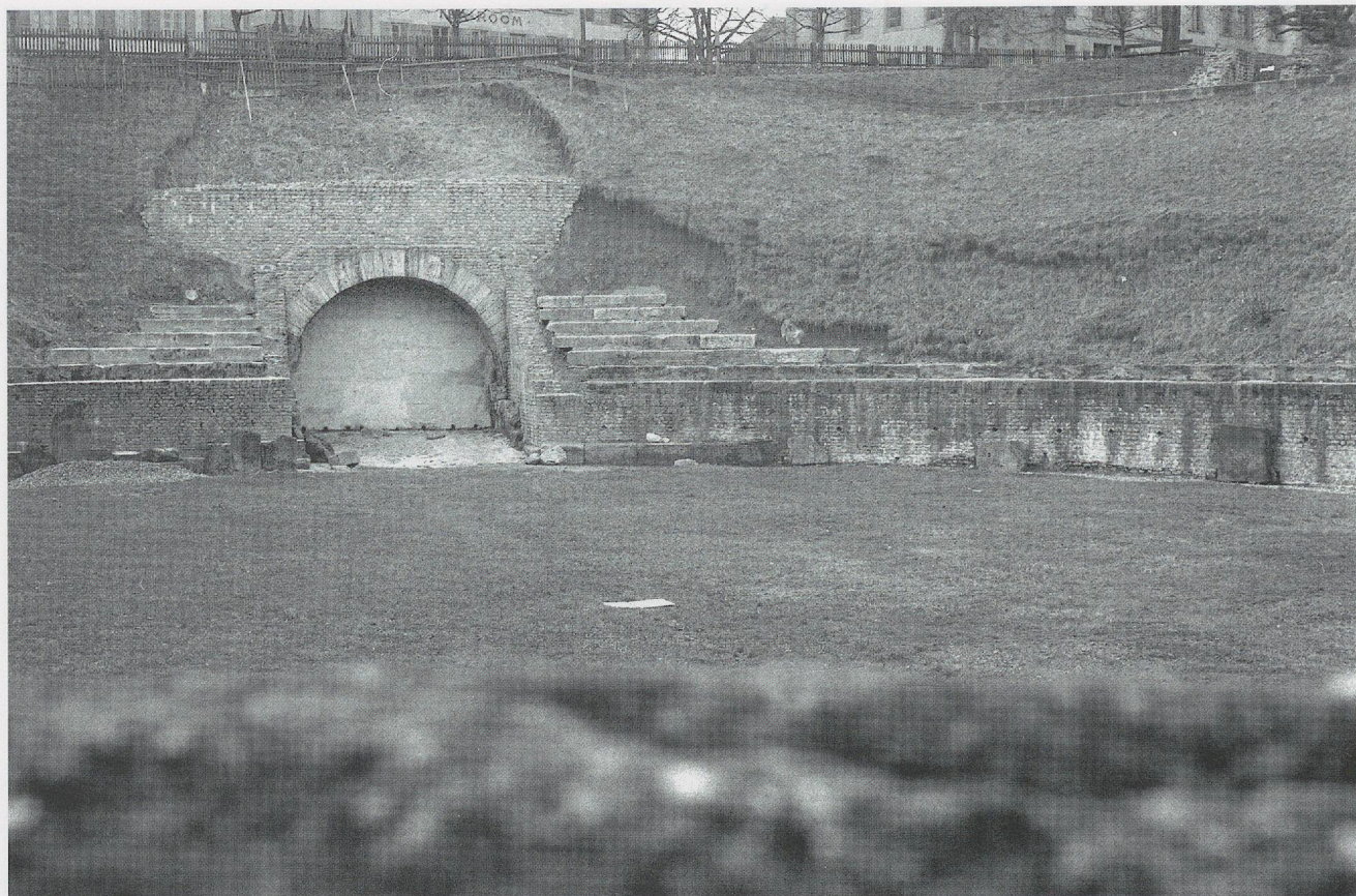
Fig. 35. Habillage en pierre naturelle de l'entrée occidentale et mise en place de quelques gradins. 9 février 1959.
