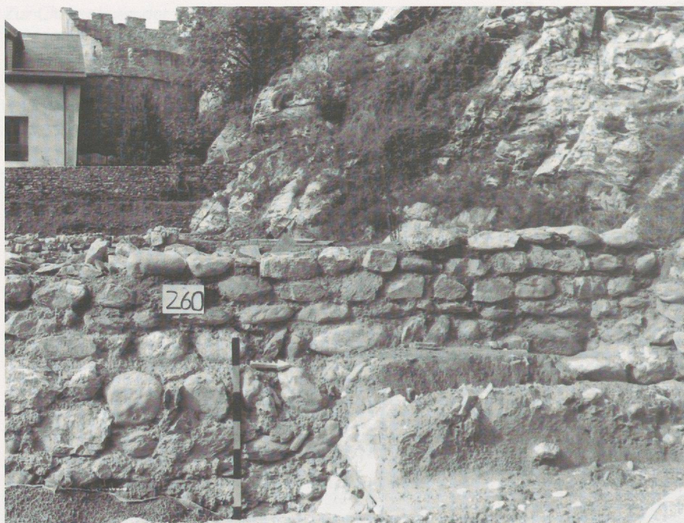
Abb. 27 Mauerwerk des nördlichen Flügelannexes (10.1990)
