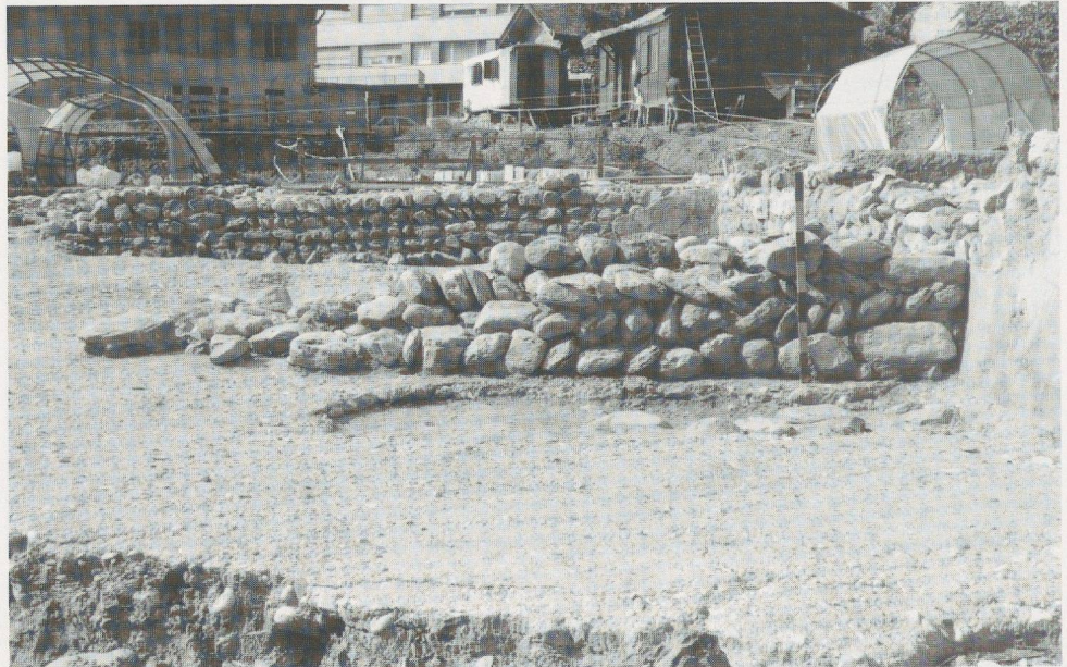
Abb. 15 Rampenkonstruktion, die vom Westannex in den Rechtecksaal hinabführt (6.1985)
