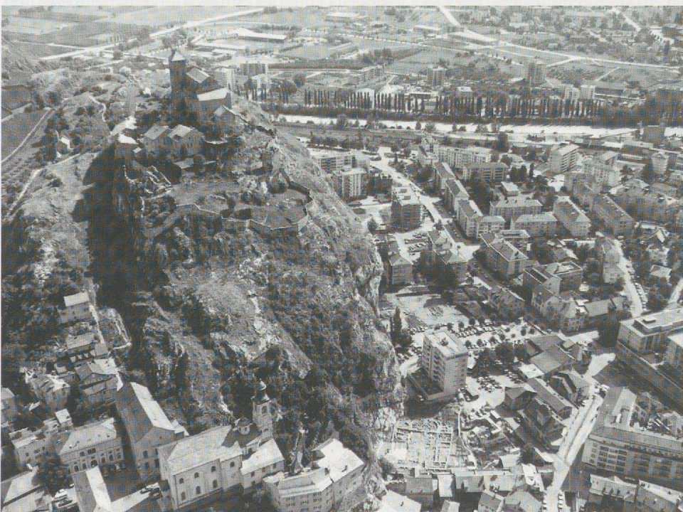
Abb.1 Das Quartier von Sitten Sous-le-Scex in einer Flugaufnahme von Westen : in der Mitte unten die Begr bniskirche ; hinter dem Hochhaus die Memorien (8.1986)
