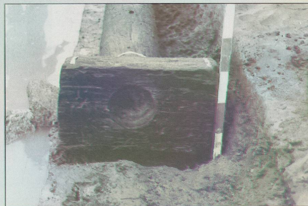
Fig. 80. Pomy-Cuarny-La Maule, la conduite gallo-romaine: le raccord B5.
