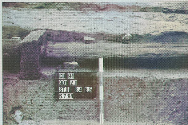
Fig. 78. Pomy-Cuarny-La Maule, la conduite gallo-romaine: le raccord B5 et le tuyau B4.
