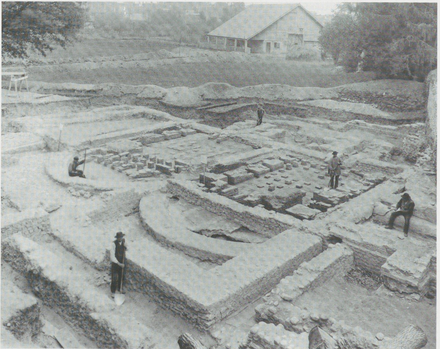
Fig. 268. Vue des fouilles des thermes du castrum en 1906 (ACV).
