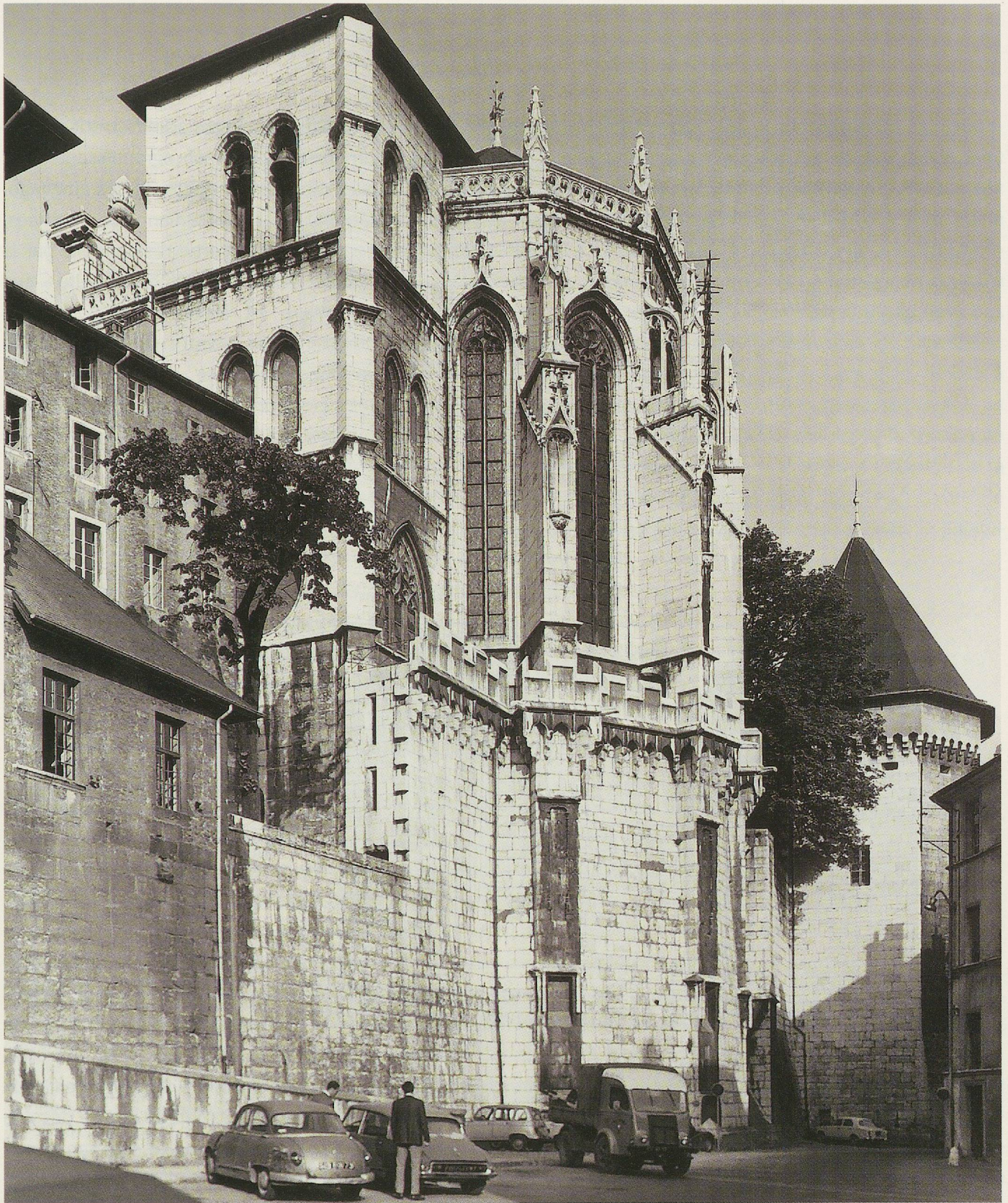
▲ Fig. 163 Château de Chambéry. Sainte-Chapelle commencée en 1408 sous Amédée VIII de Savoie, vue du sud. Une Déposition de Croix attribuée à Conrad Witz montre la chapelle non encore dotée de sa tour-clocher. Les deux travées de la nef étaient ajourées d'immenses verrières dont les traces sont visibles. Au fond, la tour du trésor.
