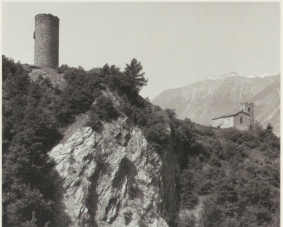
▶ Fig. 140 Saxon, ensemble castral. La tour maîtresse circulaire a été élevée par Gilles et Tassin de Saint-Georges en 1277-79; la chapelle, beaucoup plus ancienne, avait pour fonction de protéger la première porte d'accès à cet ensemble fortifié.
