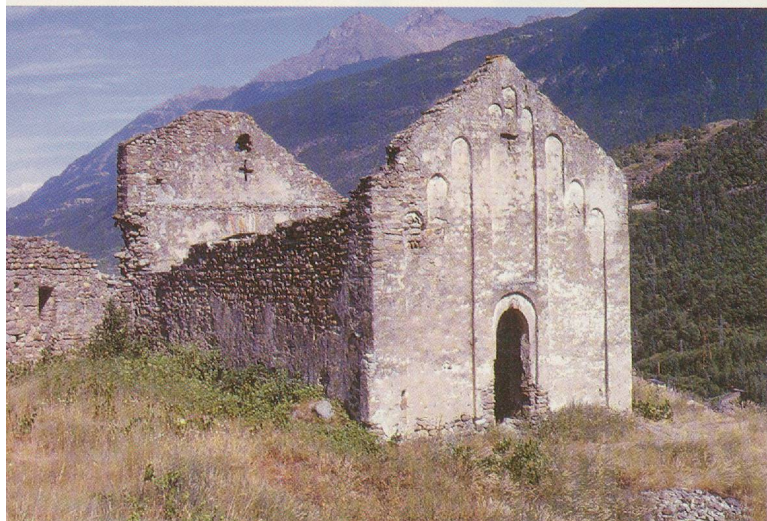
▼ Fig. 142 Châtel-Argent (Val d'Aoste, commune de Villeneuve), chapelle du bourg du château, a) façade occidentale, b) abside située à l'extérieur de l'enceinte crénelée.
