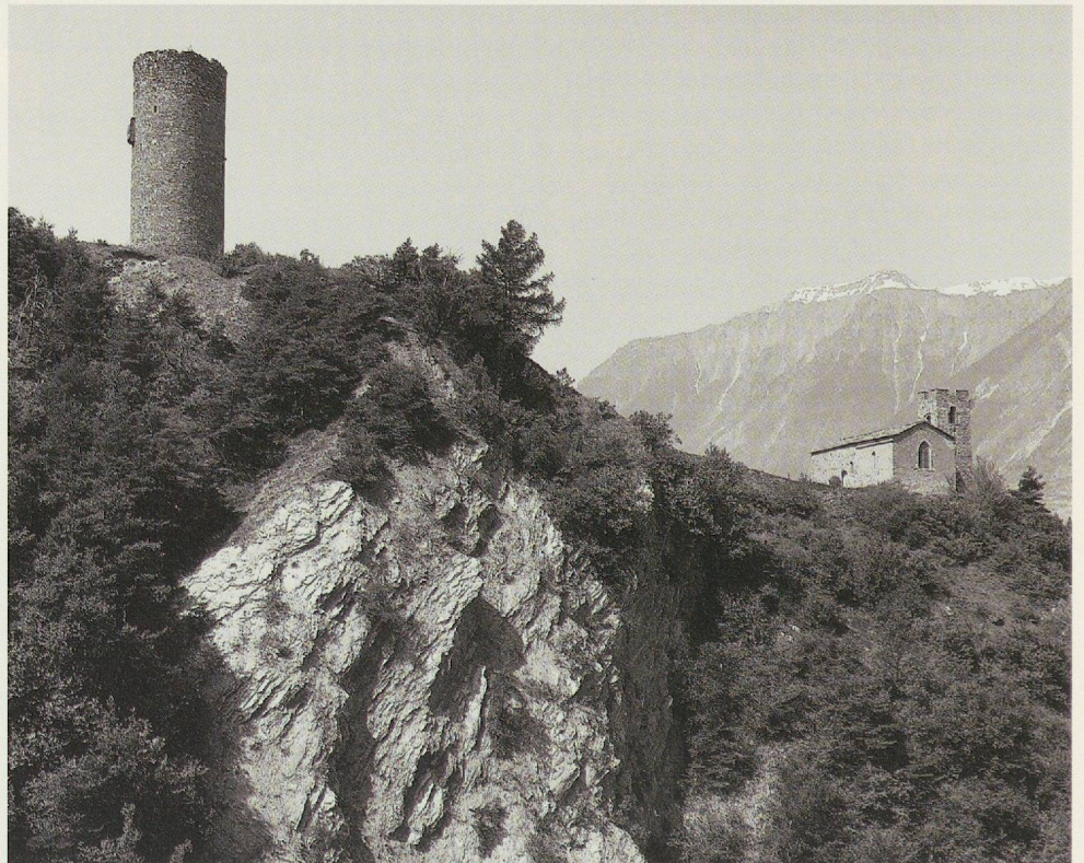
▶ Fig. 140 Saxon, ensemble castral. La tour maîtresse circulaire a été élevée par Gilles et Tassin de Saint-Georges en 1277-79; la chapelle, beaucoup plus ancienne, avait pour fonction de protéger la première porte d'accès à cet ensemble fortifié.
