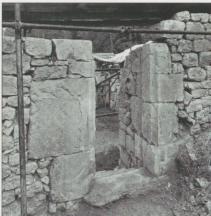
Fig. 75. Bâtiment des services, salle IX. L'encadrement extérieur de la porte tardive donnant accès au hall XII
