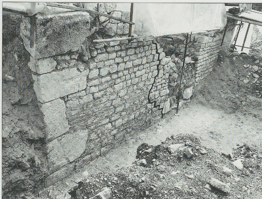
Fig. 27. L'entrée sur la façade sud de l'église (la jointure entre les deux phases de construction a été soulignée)
