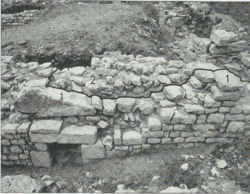
Fig. 32. Liaison de l'église et de l'annexe est (III), vue depuis l'annexe. Porte du rez-de-chaussée (phase 1) et extrados de la niche (phase 2)
