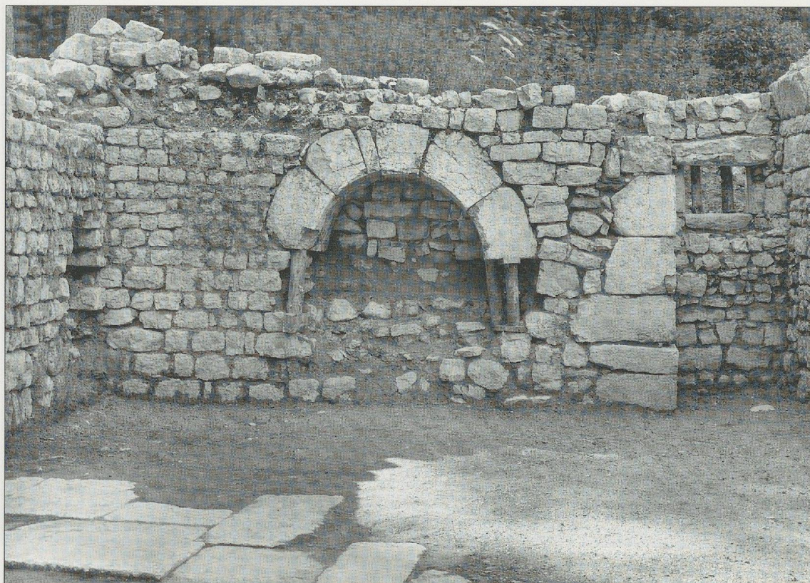
Fig. 56. Bâtiment des services, salle VII. La niche primitive et la porte transformée en fenêtre, dans le mur ouest
