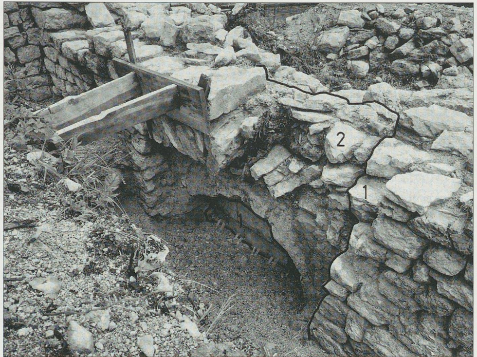
Fig. 68. Eglise, mur est. Niche (2) adossée contre l'annexe III et supprimant l'ancien escalier (1)
