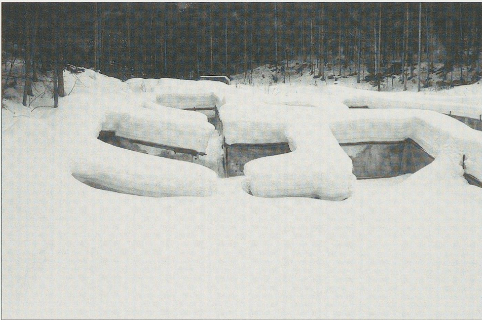
Fig. 195. Des couvertures provisoires protègent les maçonneries de l'épaisse couche de neige tombée pendant l'hiver 1980-81
