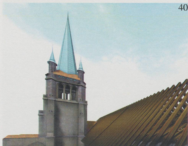
Fig. 39 et 40 Au début du XVIII e siècle, une nouvelle charpente est posée sur le chœur et la nef, déterminant une seule toiture. (Archéotech SA)
