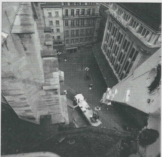
Fig. 8 Les prises de vues photogrammétriques ont été faites à l'aide d'un camion nacelle doté d'un bras de 60 mètres. (Photo O. Feihl)
