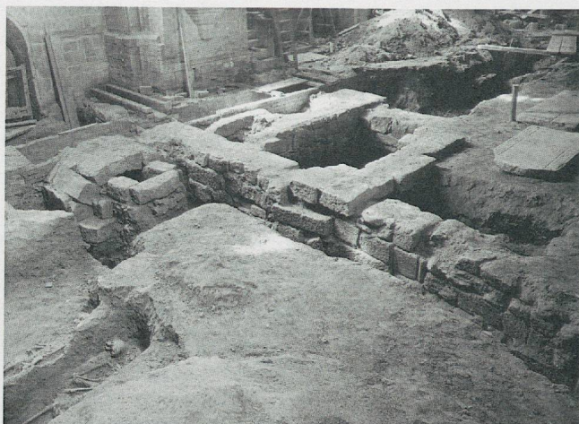
Fig. 2 André Kern Eglise Saint-François. Vue des fouilles dans la nef, au niveau de la 3 e travée et les vestiges du jubé en septembre 1930. (AChC)
