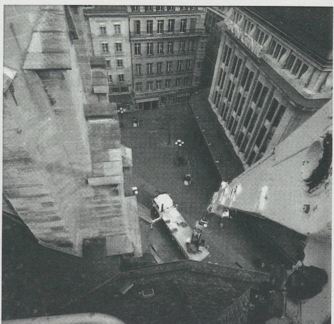
Fig. 8 Les prises de vues photogrammétriques ont été faites à l'aide d'un camion nacelle doté d'un bras de 60 mètres. (Photo O. Feihl)
