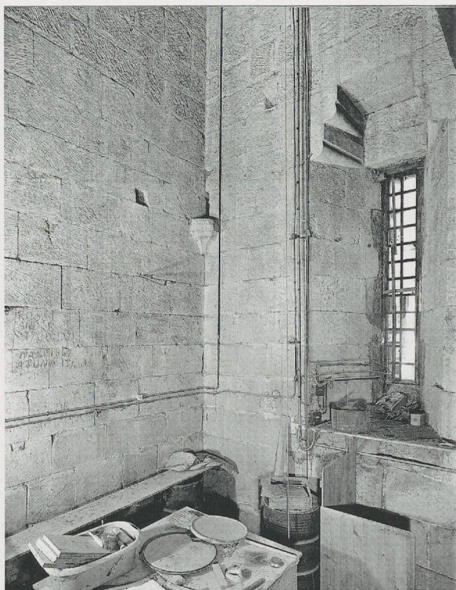
Fig. 130 Premier étage du clocher, vue intérieure, en direction du sud-ouest, septembre 1991.
