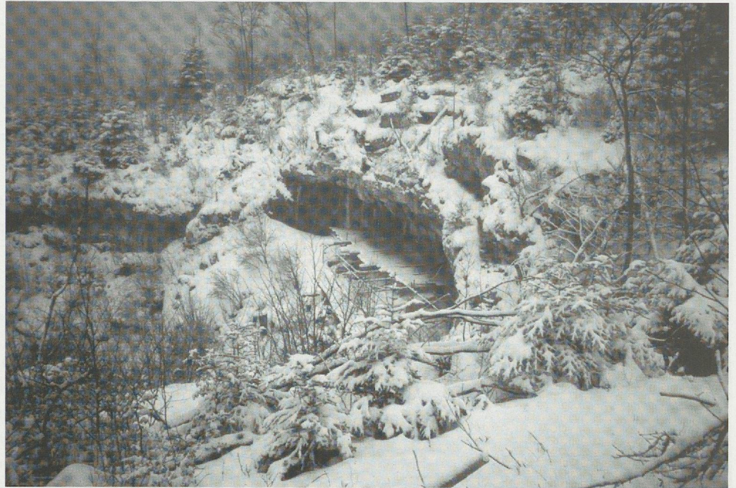
Fig. 11. Protection hivernale du chantier.
