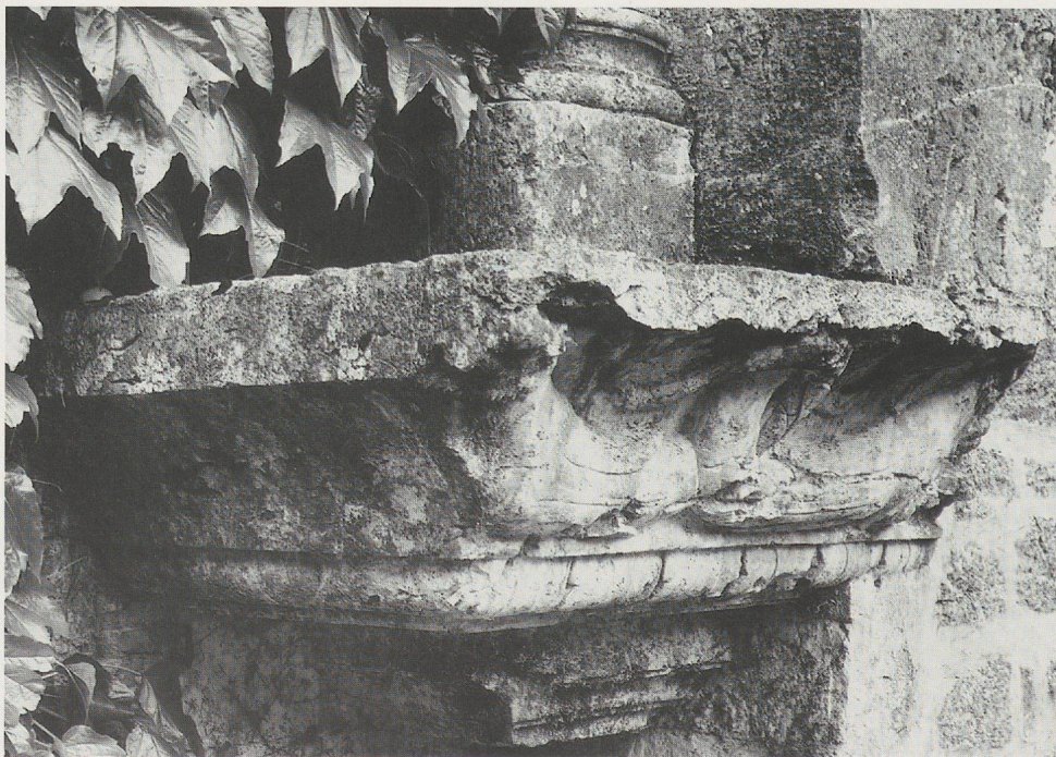
47 Gesimsblock, Münchenwiler, übereck, mit sekundär abgearbeiteter Nebenseite M 1:10
