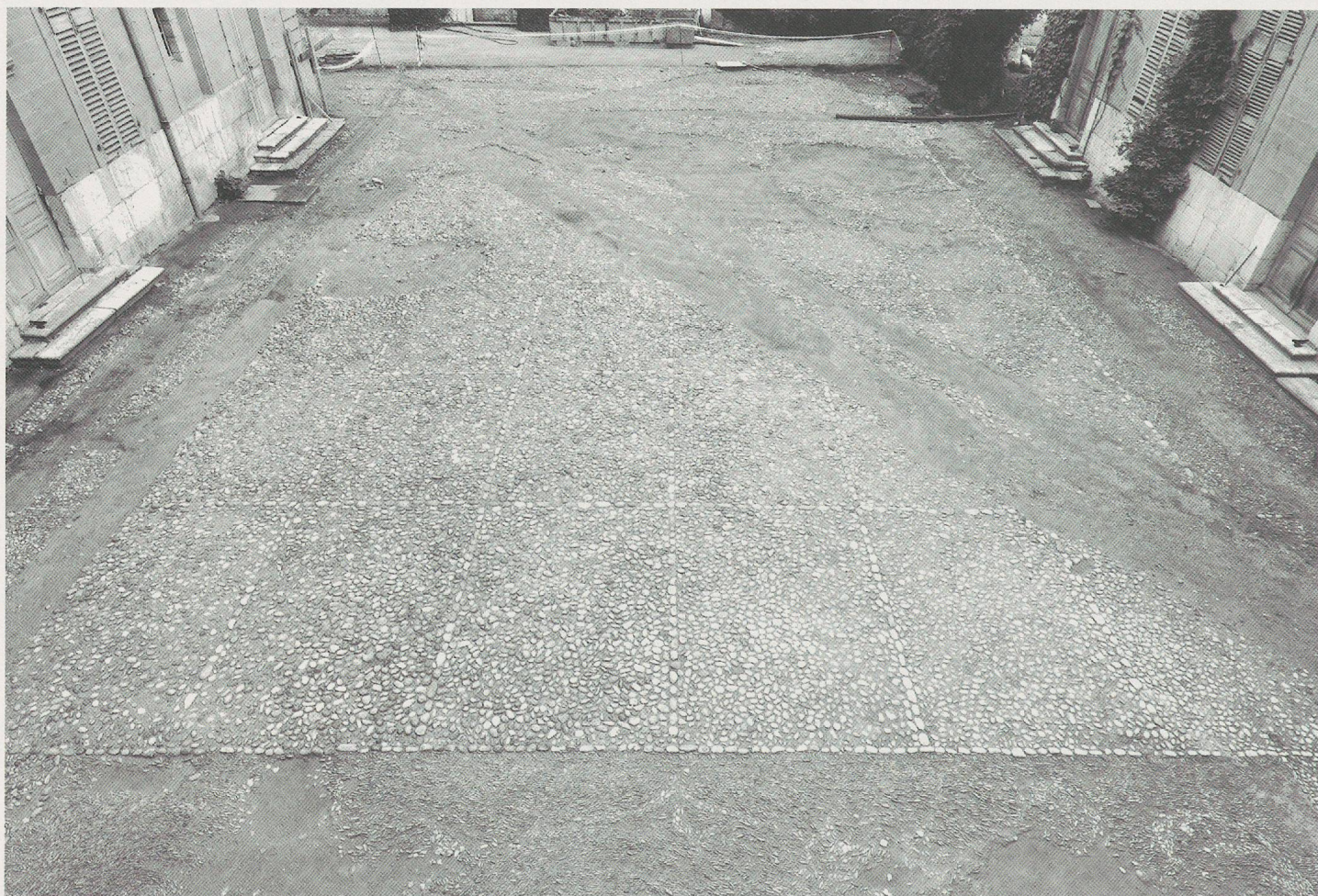
Fig. 55. Vue d'ensemble du pavage de la cour d'honneur, avec ses compartiments délimités par de plus gros boulets.
