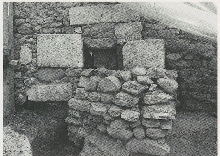
Fig. 17. Le contrefort II<sup>6</sup>, réutilisé en fondation de la chantepleure à l'étape VII.
