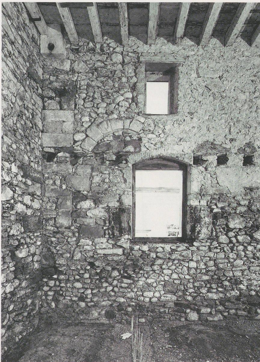
Fig. 74. Angle sud-est de la dépendance, avec la chaîne d'angle du premier état et l'arc couvrant un percement du deuxième.
