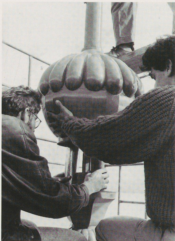
Fig. 90. Introduction dans l'épi de faitage des deux tubes contenant les documents anciens et nouveaux.
