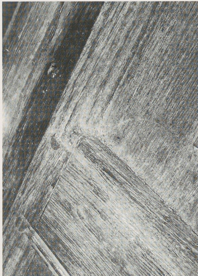
Fig. 79. Assemblage au carré d'un montant et d'une traverse. La moulure, taillée avec quelque maladresse, tombe sur une cheville; elle pourrait avoir été taillée après l'assemblage.
