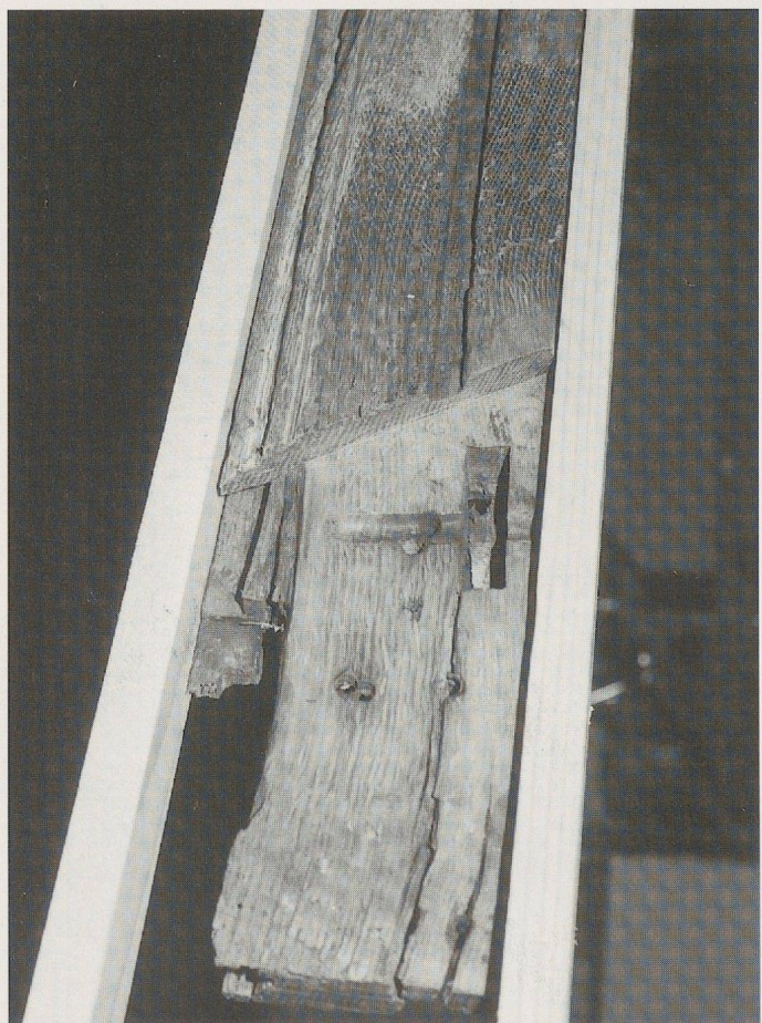
Fig. 78. Un montant en cours de restauration. On distingue les entailles faites pour le tenon qui assurait autrefois la fixation du pilier rapporté formant battement et, perpendiculairement, pour la cheville ronde fixant ce tenon. On remarque également la rainure qui recevait le pilier installé lors de la précédente restauration.
