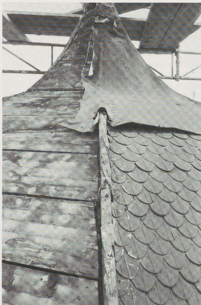
Fig. 88. Le clocher en cours de restauration. On distingue encore, à droite, les écailles en fer-blanc qui le recouvraient et, à gauche, la forme en bois du toit à l'impériale sur laquelle elles étaient fixées.
