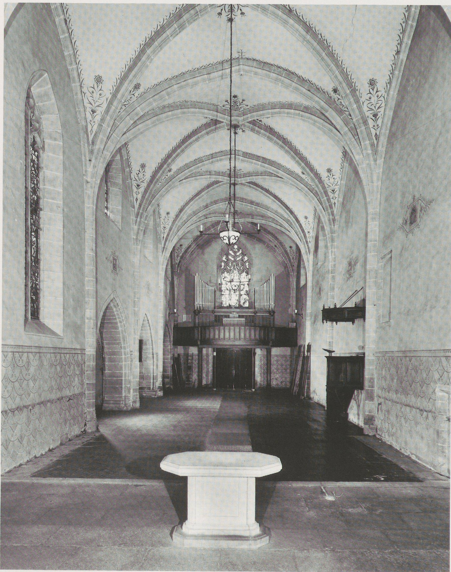
Fig. 47. Intérieur de l'église, avant restauration; vue vers l'ouest.
