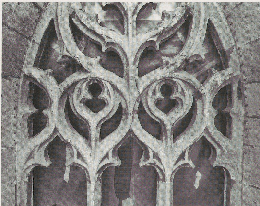
Fig. 44. Façade ouest de l'église; remplage de la fenêtre.
