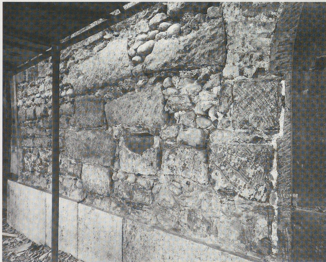
Fig. 41. Façade ouest de l'église; maçonneries de la chapelle.
