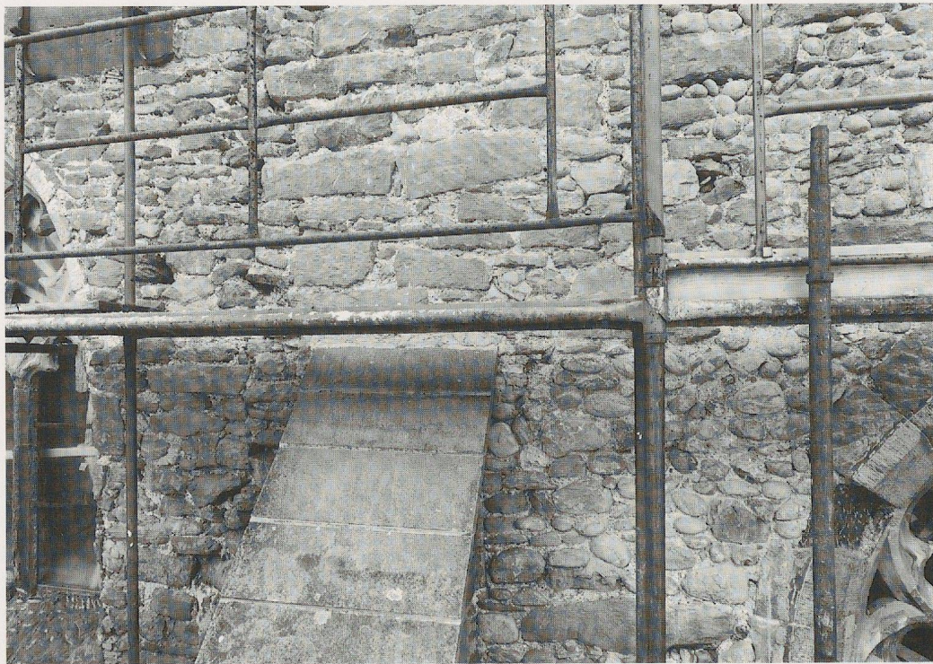
Fig. 37. Façade sud de l'église; césure entre les structures de la nef et du chœur, à la hauteur du contrefort.
