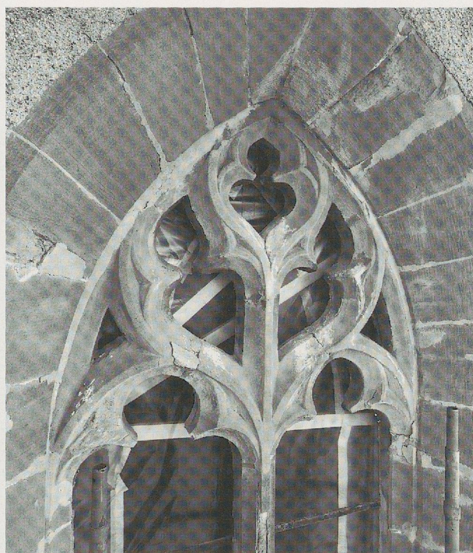
Fig. 46. Façade sud de l'église; remplage de la deuxième fenêtre du chœur.
