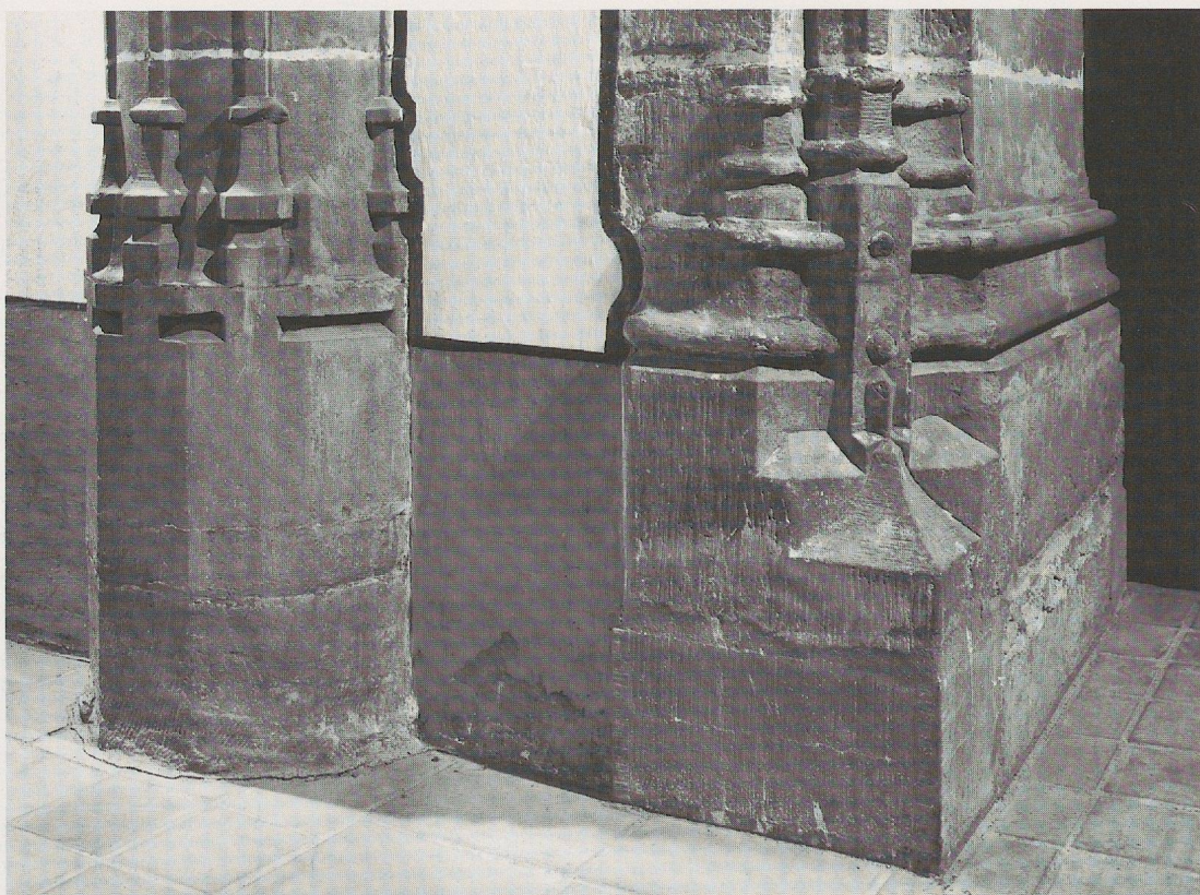
Fig. 49. Bases d'une colonne engagée de la nef et du piédroit oriental de la troisième chapelle sud.
