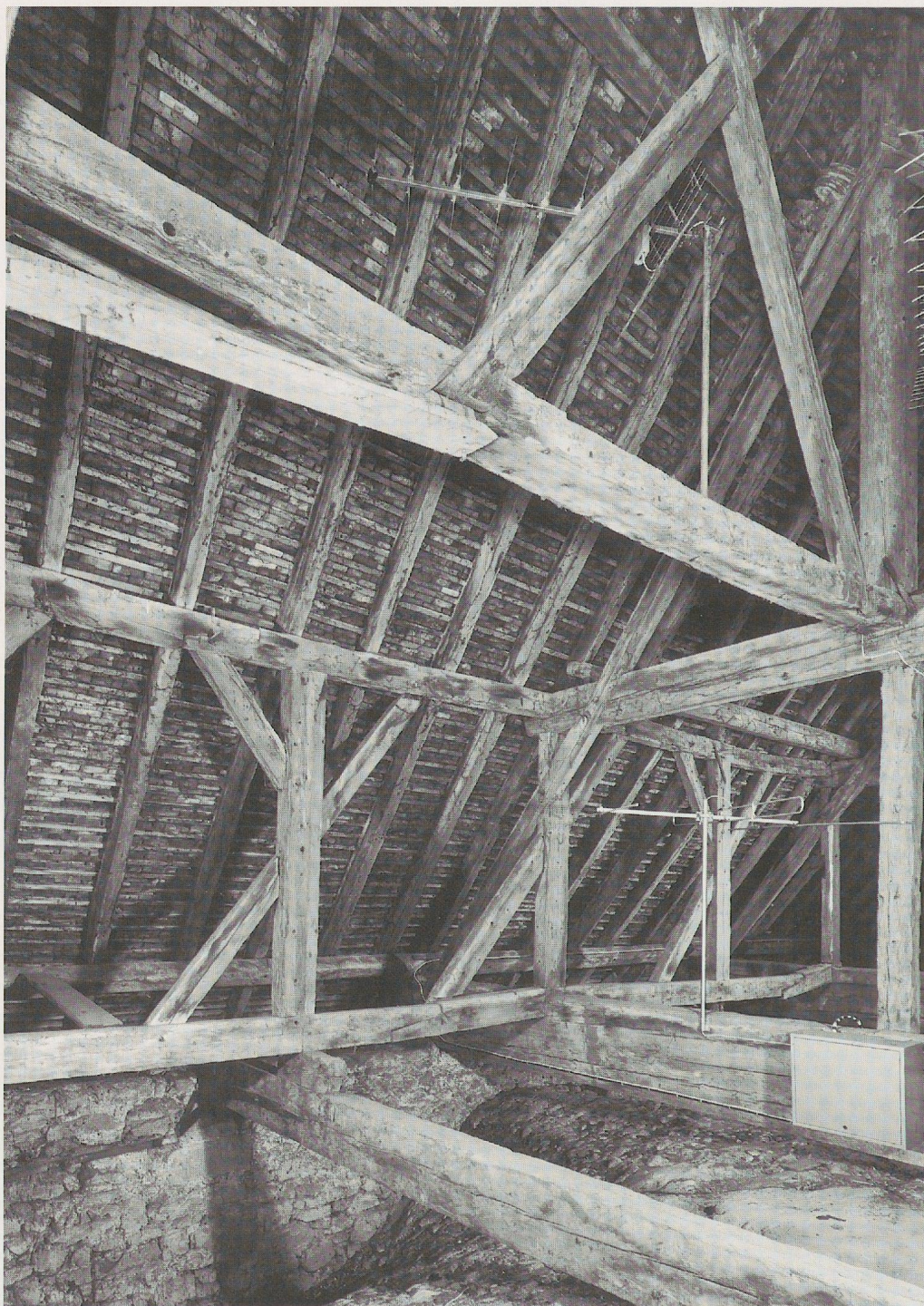
Fig. 59. La charpente de la nef; vue vers le nord-est.
