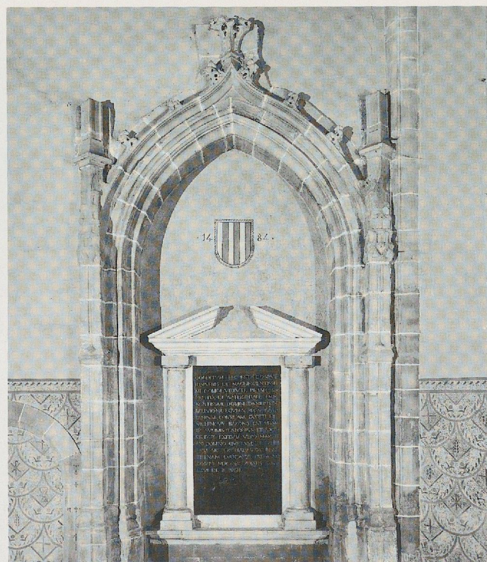
Fig. 74. L'enfeu, avant sa restauration.
