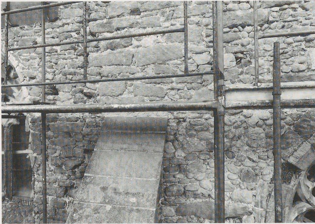
Fig. 37. Façade sud de l'église; césure entre les structures de la nef et du chœur, à la hauteur du contrefort.
