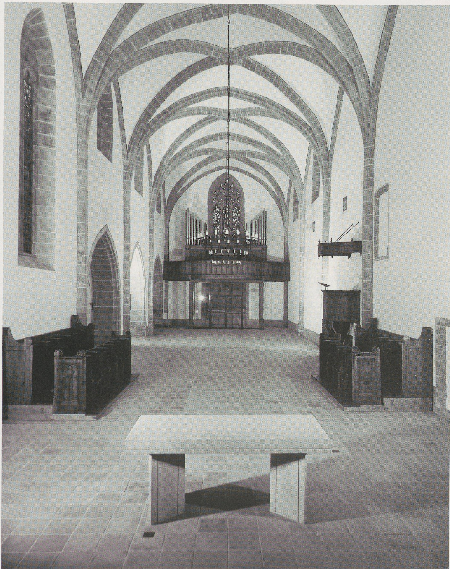
Fig. 48. Intérieur de l'église, après restauration; vue vers l'ouest.
