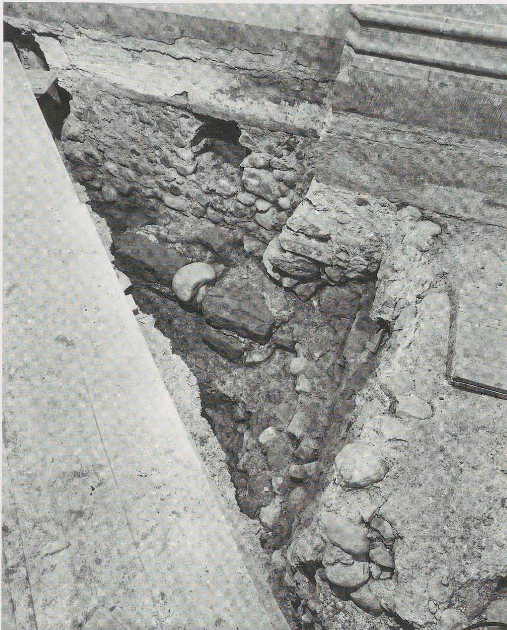
Fig. 27. Troisième chapelle à l'intérieur de l'église, mur sud et contrefort (entre les 2 e et 3 e chapelles); vue vers le sud-ouest.
