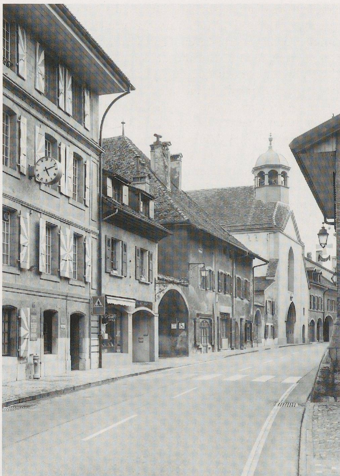
Fig. 15. La rangée orientale de la Grand-Rue, entre l'hôtel de ville et la ruelle du Lac. État avant la dernière restauration.
