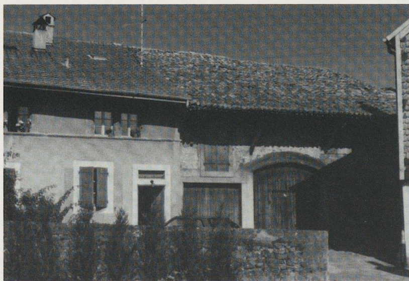
Fig. 154. Gilly, rural portant la date de 1643 sur la porte de grange. Toiture peu inclinée couverte de tuiles canal sans crochet posées sur des sortes de chevrons de section triangulaire.
