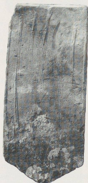
Fig. 40. Il n'est pas rare que la surface extérieure de ces tuiles soit d'aspect particulièrement peu soigné, ce qui peut faire douter de l'efficacité des gouttières. Première moitié du XVII e siècle (Orny, maison d'Entreroches).
