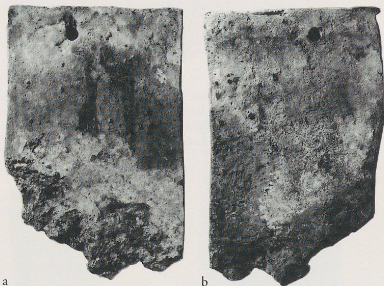
Fig. 116a-b. Tuile fragmentaire dotée d'un seul trou, décentré, comme unique moyen de fixation au lattage (Chésèrex, église Notre-Dame de Bonmont).
