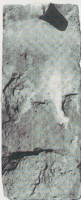
Fig. 37a-b. Les tuiles moulées «à l'allemande» dont la surface extérieure est lissée sont très peu nombreuses. La découpe droite et le talon trapézoïdal soigneusement façonné permettent de situer ce modèle par comparaison entre le XIII e et le XVI e siècle (Avenches, Tour du Musée).
