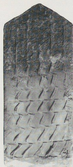
Fig. 195a-b. Tuiles à larges cannelures ondulantes (a) et ondulations en dents de scie (b) tracées avec un outil (a. Agiez, cure; b. Bretonnières, église).
