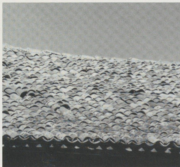
Fig. 154. Gilly, rural portant la date de 1643 sur la porte de grange. Toiture peu inclinée couverte de tuiles canal sans crochet posées sur des sortes de chevrons de section triangulaire.
