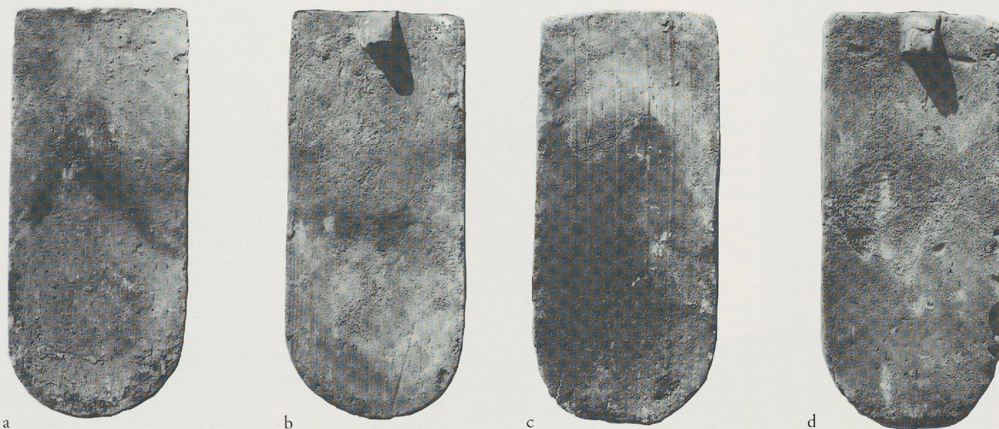
Fig. 73a-d. Tuiles à découpe arrondie et en tout point identiques mis à part le traitement de la surface extérieure, tantôt lissée (a-b), tantôt à larges cannelures tracées avec un outil (c-d) (Payerne, église paroissiale).
