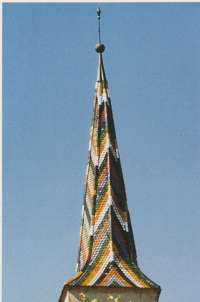
Fig. 60. Clocher de l'église de Granges-Marnand reconstruit en 1808. Tuiles vernissées de différentes couleurs posées selon un motif de chevrons (couverture reconstituée lors de la restauration de 1968).
