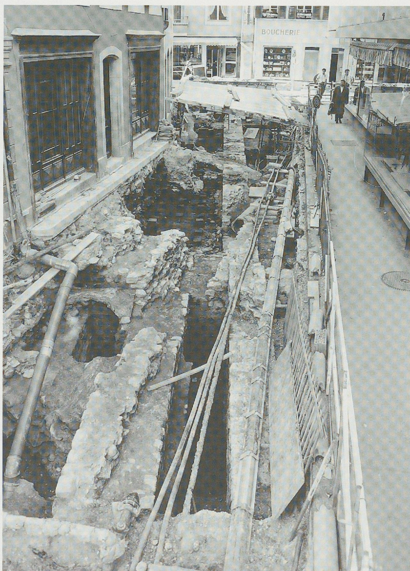
Fig. 74. Rue du Marché 1990: vue générale de la fouille des thermes.
