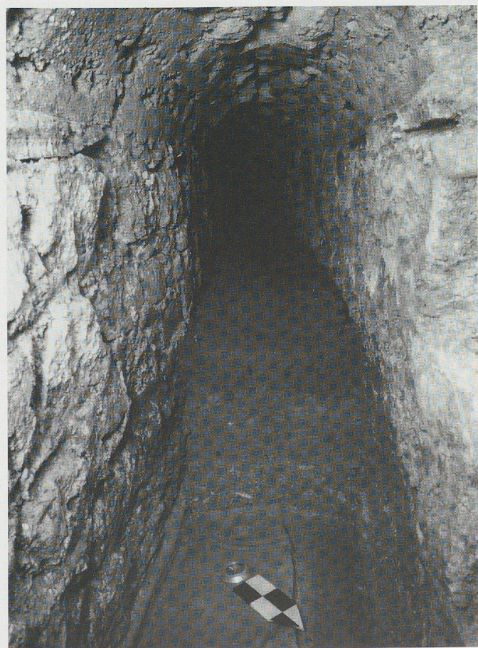
Fig. 52. Vue intérieure de l'égout st.39.
