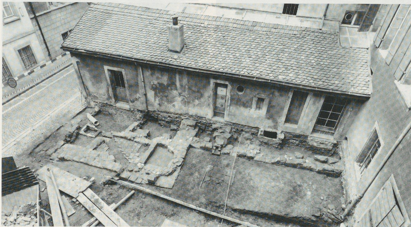
Fig. 30. La cour basse, vue vers l'ouest, avec la maison Dapples à l'angle.
