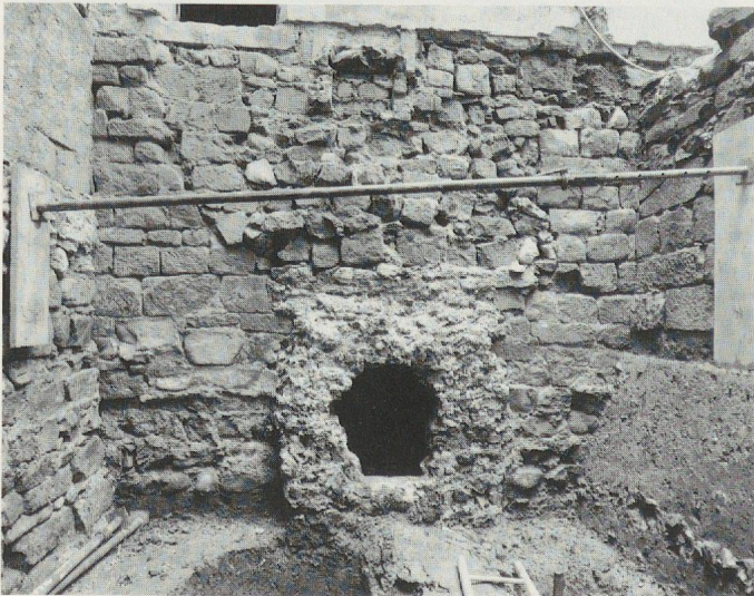
Fig. 16. La cour haute: la façade est du bâtiment principal.
