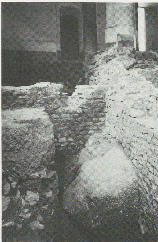
Fig. 7: Vue du mur gallo-romain, fondé en partie sur la roche, avec son fruit
