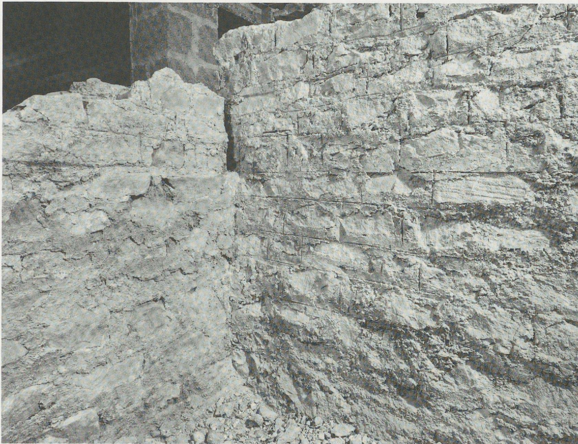
Fig. 9: Vue de la maçonnerie gallo-romaine avec jointoyage en pietra rasa
