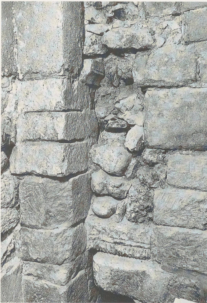
Fig. 55. Tailloir sculpté de l'arc triomphal, surmonté par l'imposte du pilier engagé du mur nord; vue vers le nord-est.
