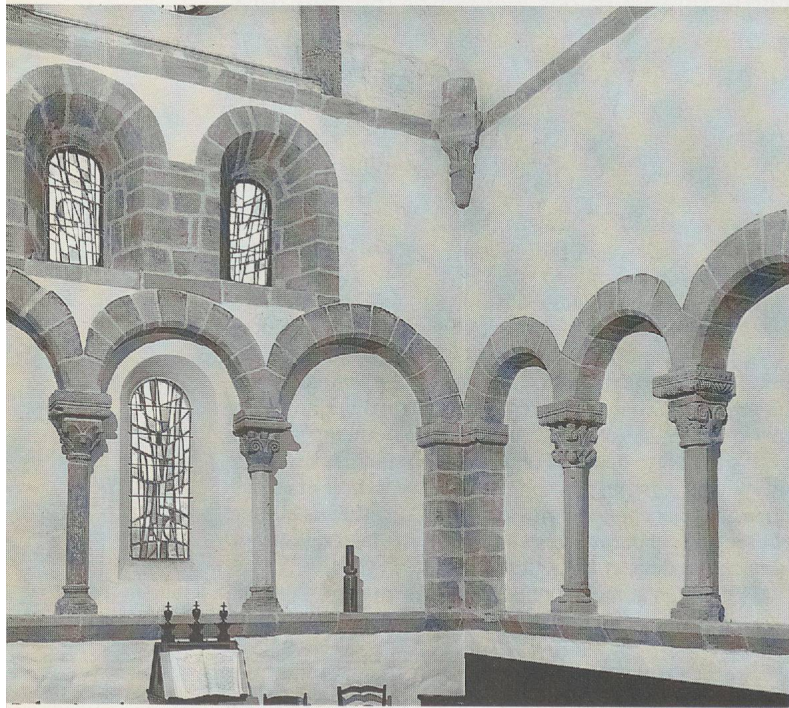
Fig. 56. Arcature du chœur, vue vers le sud-est.
