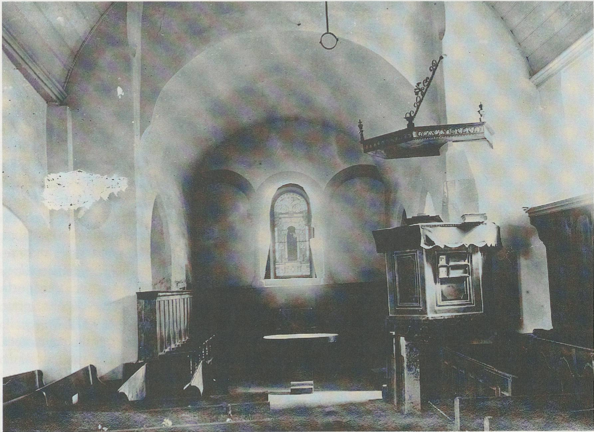
Fig. 25. Vue du chœur de l'église avant la restauration de 1911-1913.
