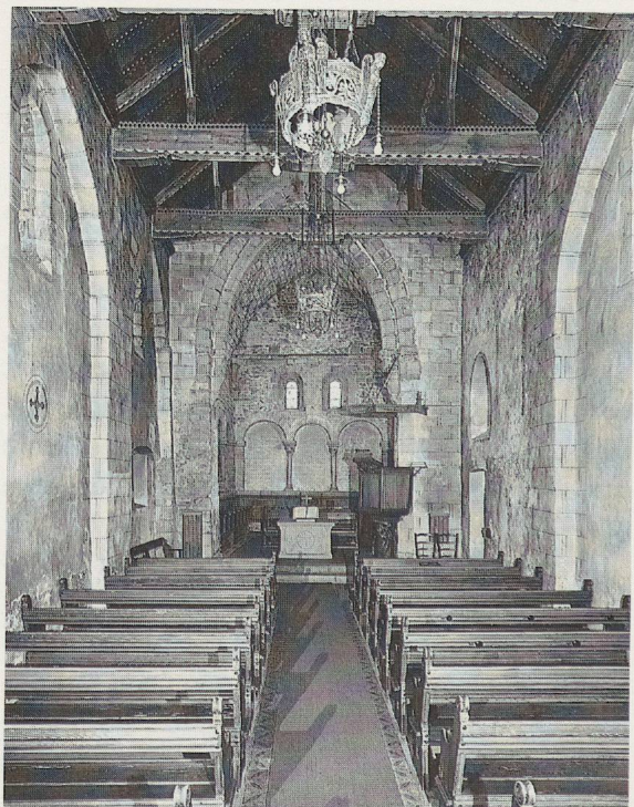
Fig. 2. L'église avant la dernière restauration, intérieur, vue vers le chœur.
