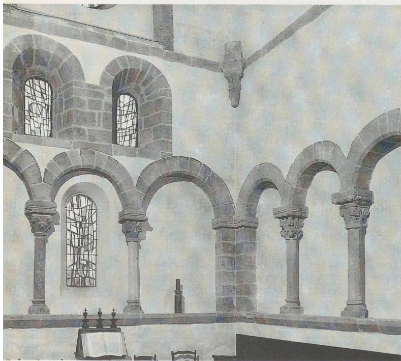
Fig. 56. Arcature du chœur, vue vers le sud-est.
