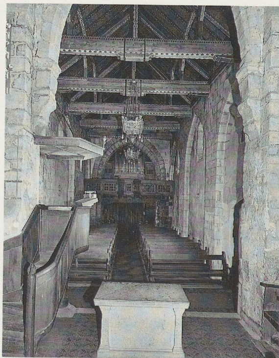
Fig. 3. L'église avant la dernière restauration, intérieur, vue vers le porche.
