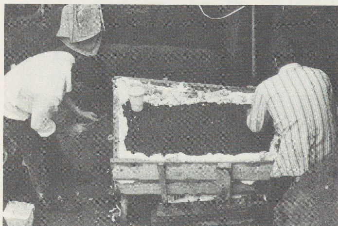
Fig. 11 Corseaux «en-Seyton». Coulage de la mousse de polyuréthane expansée; des interstices ont été aménagés pour faciliter le durcissement et laisser s'écouler le surplus.
