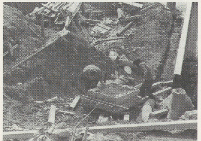
Fig. 13 Corseaux «en-Seyton». Evacuation du chantier d'une tombe coffrée, le câble est fixé à la structure porteuse.
