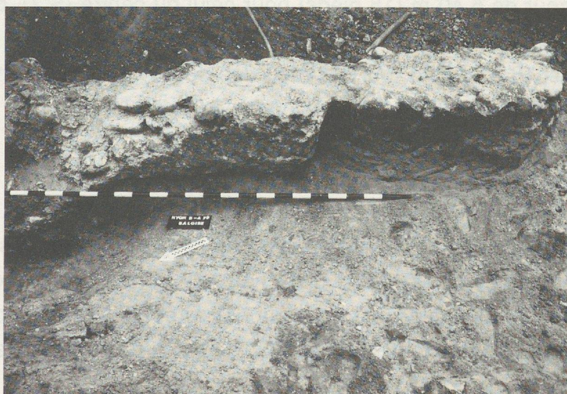
Fig.25. Zone B: mur de contrefort 317 du bâtiment nord de la domus (état 3A).
