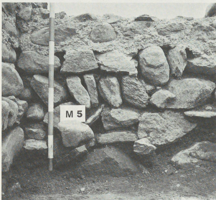
Fig. 134. Bât. est : vue latérale de la poterne (st. 20), vue ouest.
