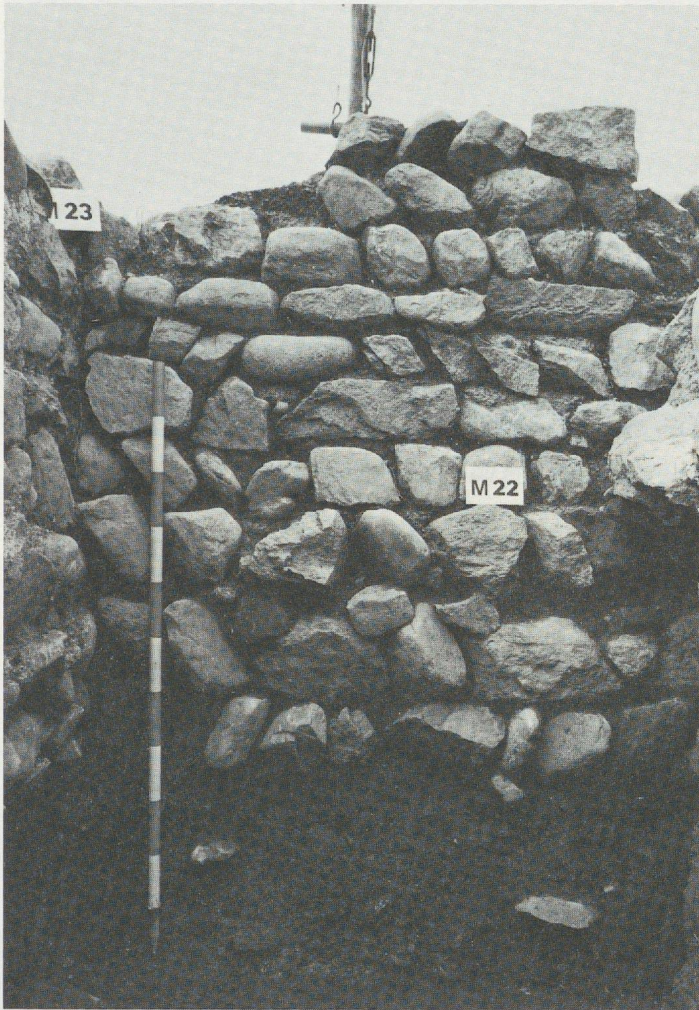
Fig. 100. Bât. est: liaison des murs M22 et M23, vue ouest.
